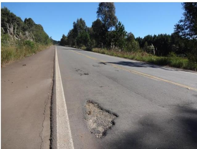
Figura 7: Buracos, afundamentos e recalques no pavimento km 223
