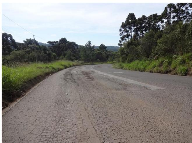
Figura 24: km 12,8 - Buracos e afundamento pavimento
