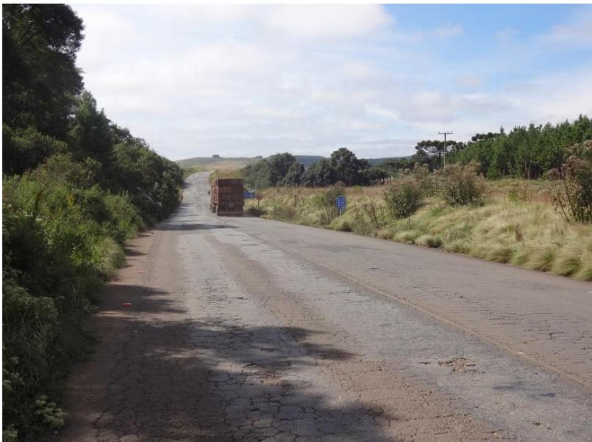
Figura 18: Desagregação do pavimento - km 116
