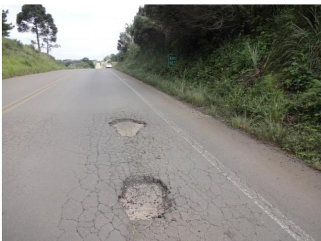
Figura 14: km 154 - Buracos e trincamento pavimento
