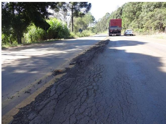
Figura 3: Afundamentos recalques da pista - Km 178
