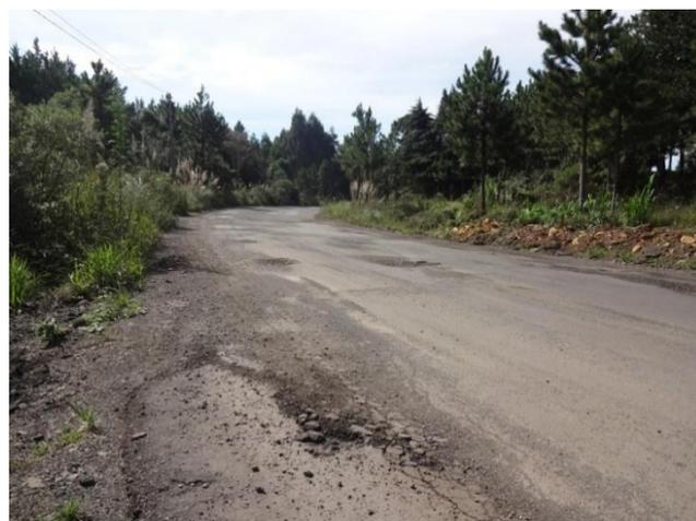
Km 21,5 – Afundamentos e recalques na pista
