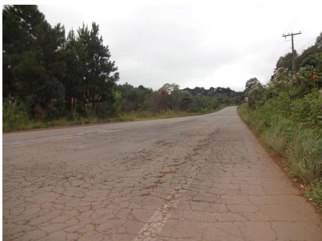
Figura 12: km 163,7 - Trincamento do pavimento
