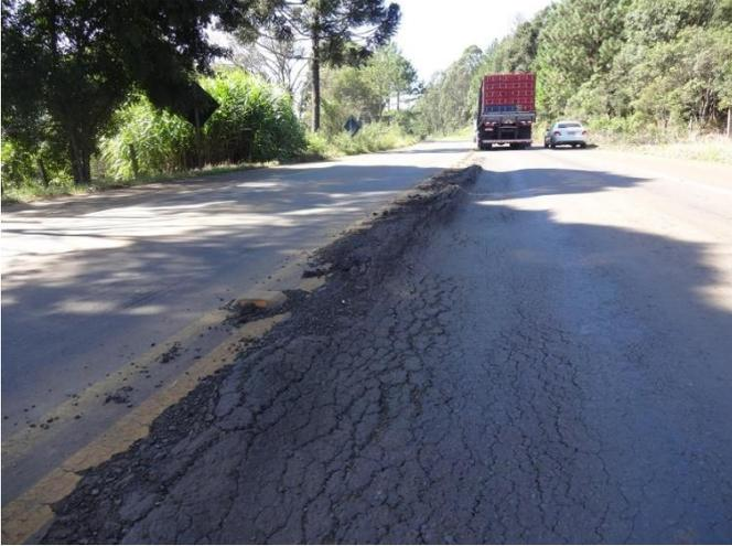
Km 178 – Afundamentos e recalques da pista
