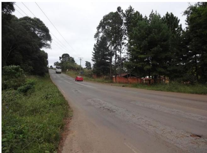
Figura 10: km 175 - Recalques e buracos no pavimento
