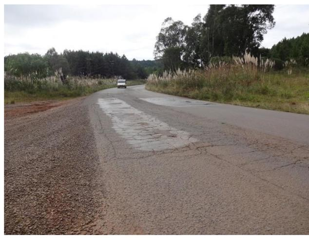
Figura 15: km 133 - Trilha de roda, trincamento e desagregação
