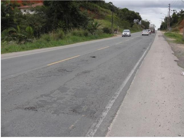
Km 105 - Afundamentos, recalques e desagregação do pavimento
