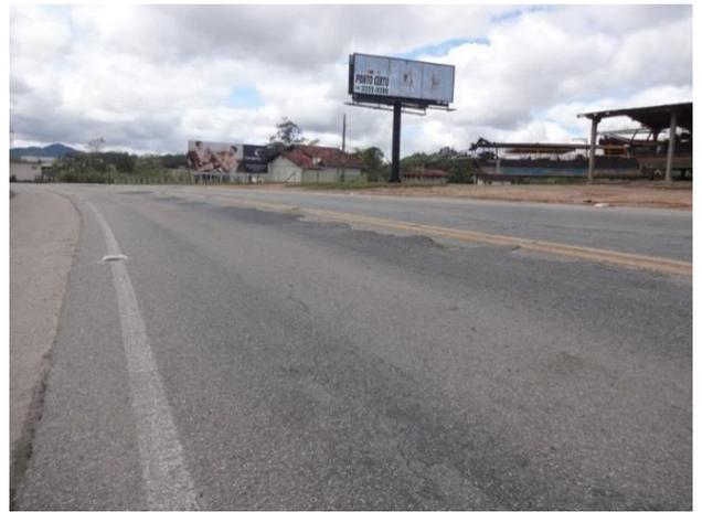
Km 20,2 - Operação "tapa buraco" sobre pavimento afundando
