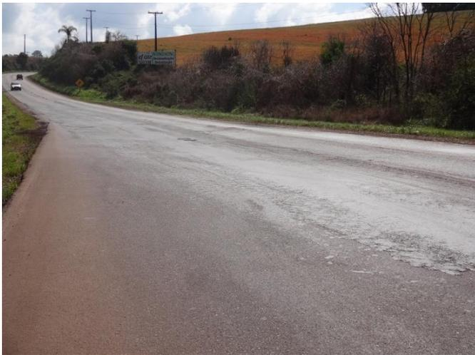
Km 82,5 - Trilha de roda e afundamento do pavimento
