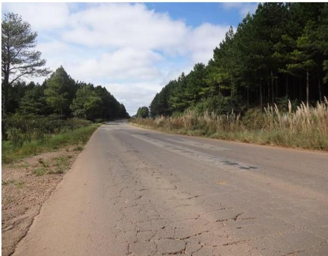
Figura 16: km 129,5 - Trincamento do pavimento
