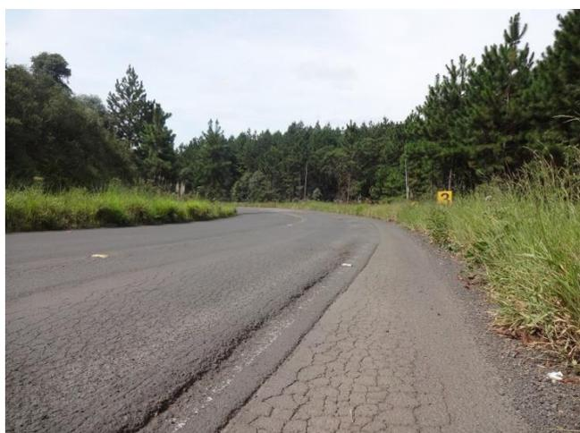
Figura 22: km 8,5 – Trilha de roda, trincamento e desagregação do pavimento
