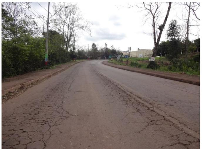
Mondáí- Rio das Antas- Trilha de roda, trincamento e desagregação do pavimento
