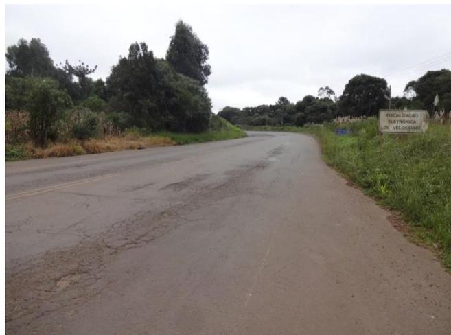
Figura 11: Trincamento e desagregação do pavimento - km 171
