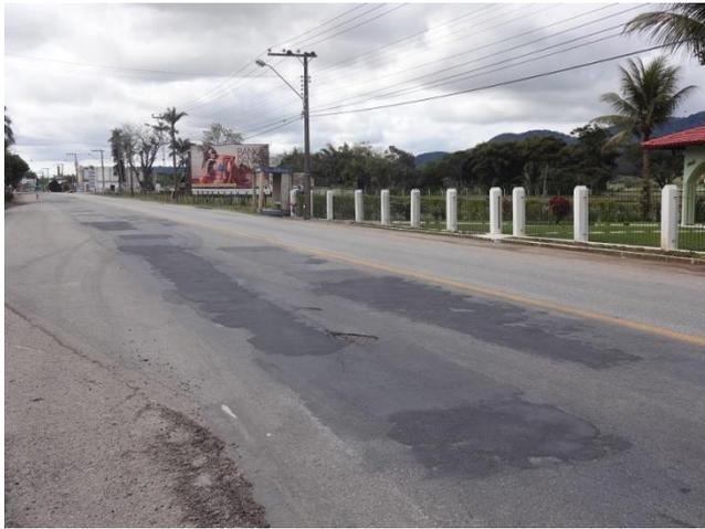
Execuções de "remendos" sobre pavimento danificado
