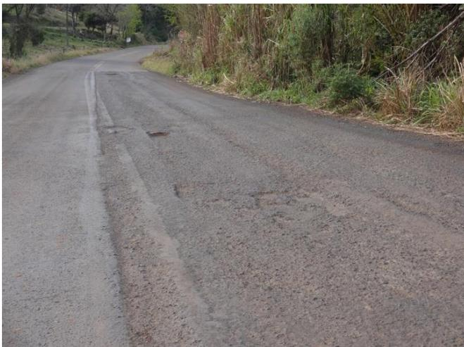
Buracos, afundamentos e recalques do pavimento - km 86
