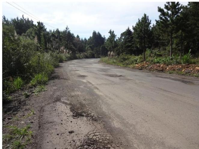
Figura 27: km 21,5 - Afundamentos e recalques na pista
