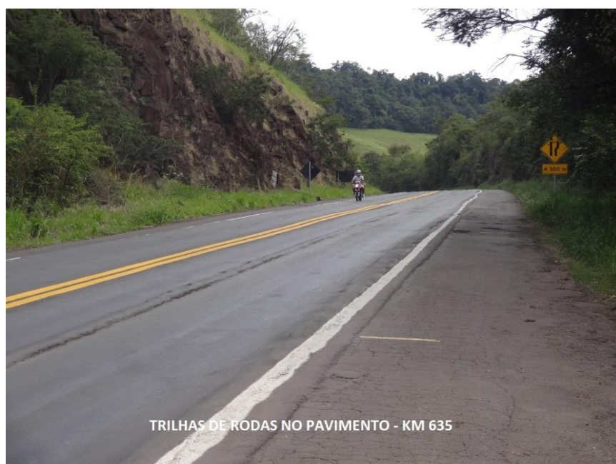
TRECHO NUMA EXTENSÃO DE APROXIMADAMENTE 1.500 METROS COM TRILHAS DE RODAS PROFUNDAS - KM 634,5
