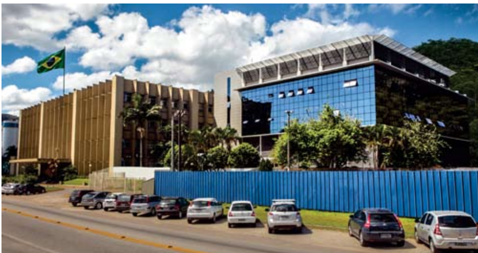
Bloco Santa Catarina possui quatro pavimentos e área total de 4,1 mil metros quadrados
