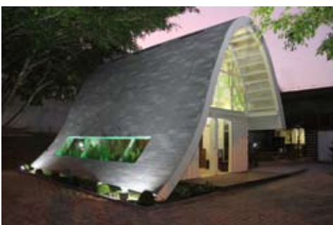
Capela foi construída a partir de contêineres
