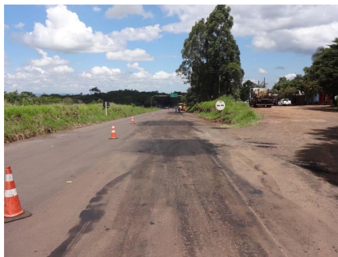
Figura 12: Execuções de drenagens profundas e recomposição do revestimento no km 644,5 (Próximo acesso BR-163.SC)
