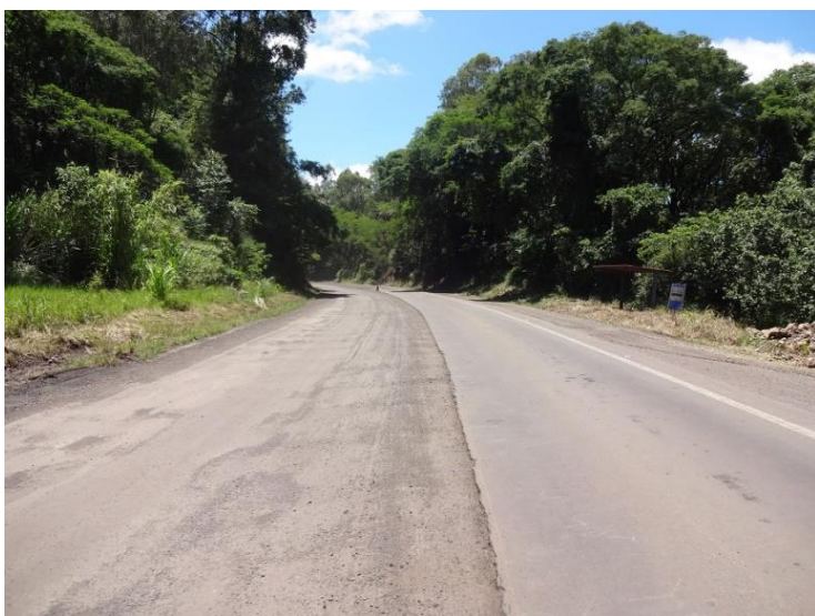
Figura 8: Km 613,1 - Obras de correção da capa asfáltica por meio de fresagem contínua
