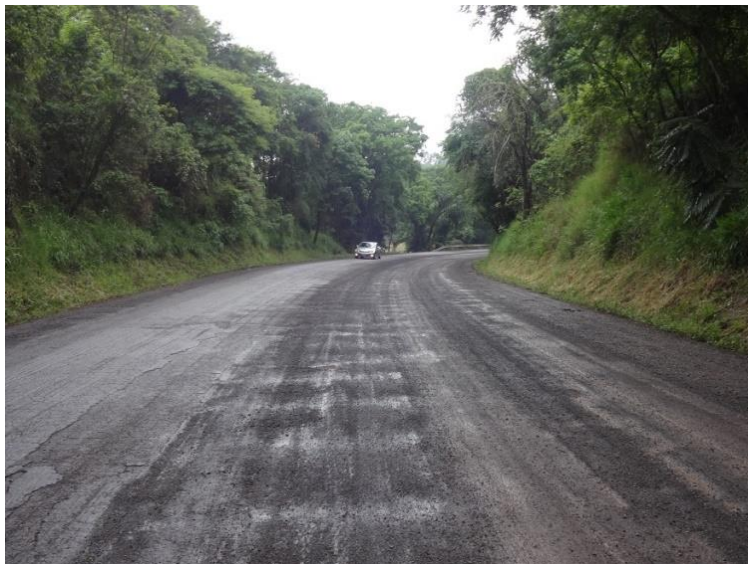
Figura 10: Fresagem contínua de toda a pista e correção de defeitos, entre km 613 e 614 (Próximo a Maravilha)
