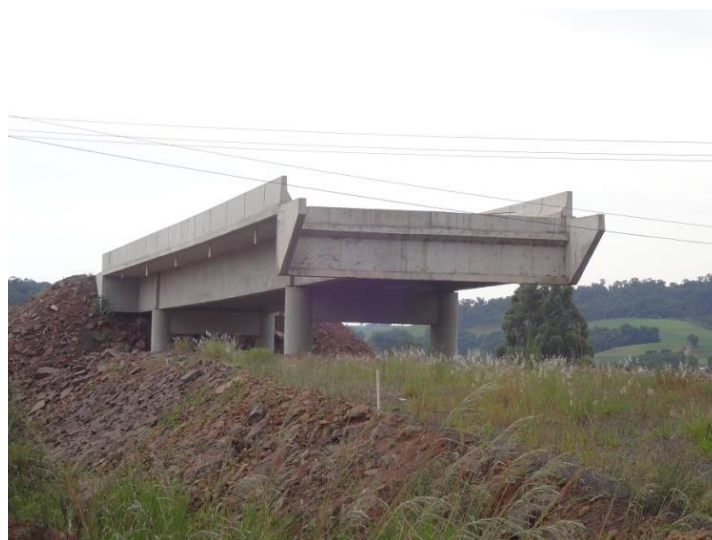
Figura 21: Viaduto de acesso a São José do Cedro - km 101,3
