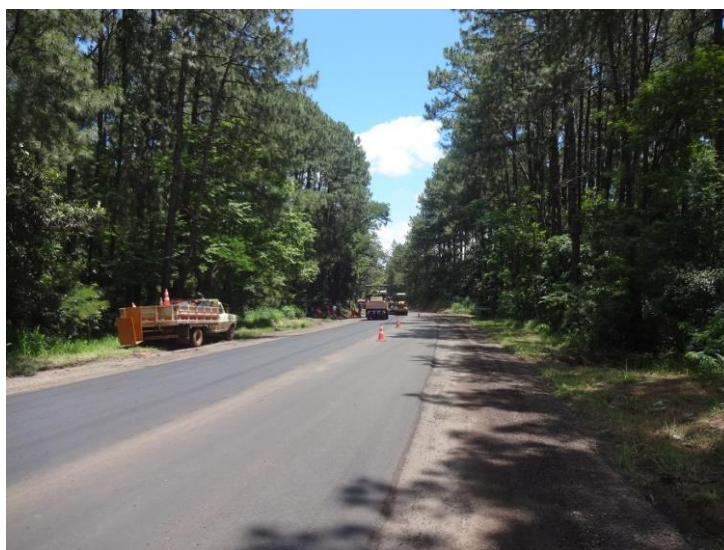
Figura 9: Km 611,8 - Recomposição da capa asfáltica com mistura betuminosa usinada quente (MBUQ)
