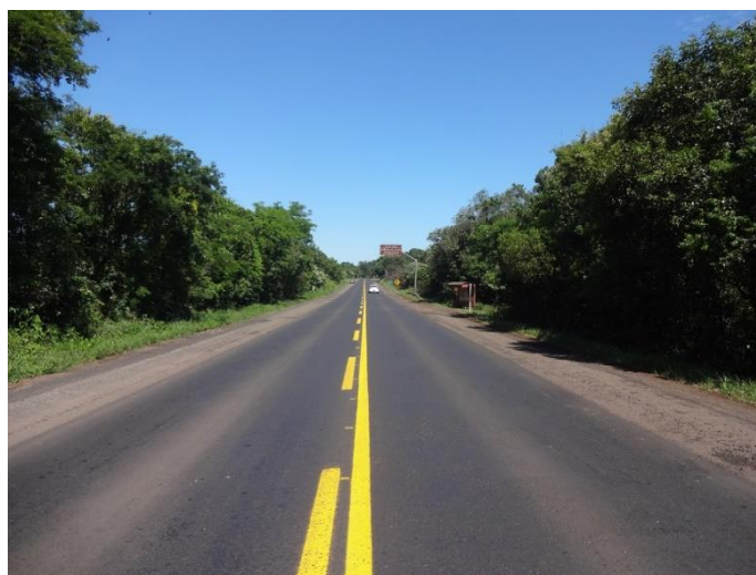
Figura 11: Pista restaurada e sinalizada - km 604 (Maravilha/ Acesso BR-158.SC)
