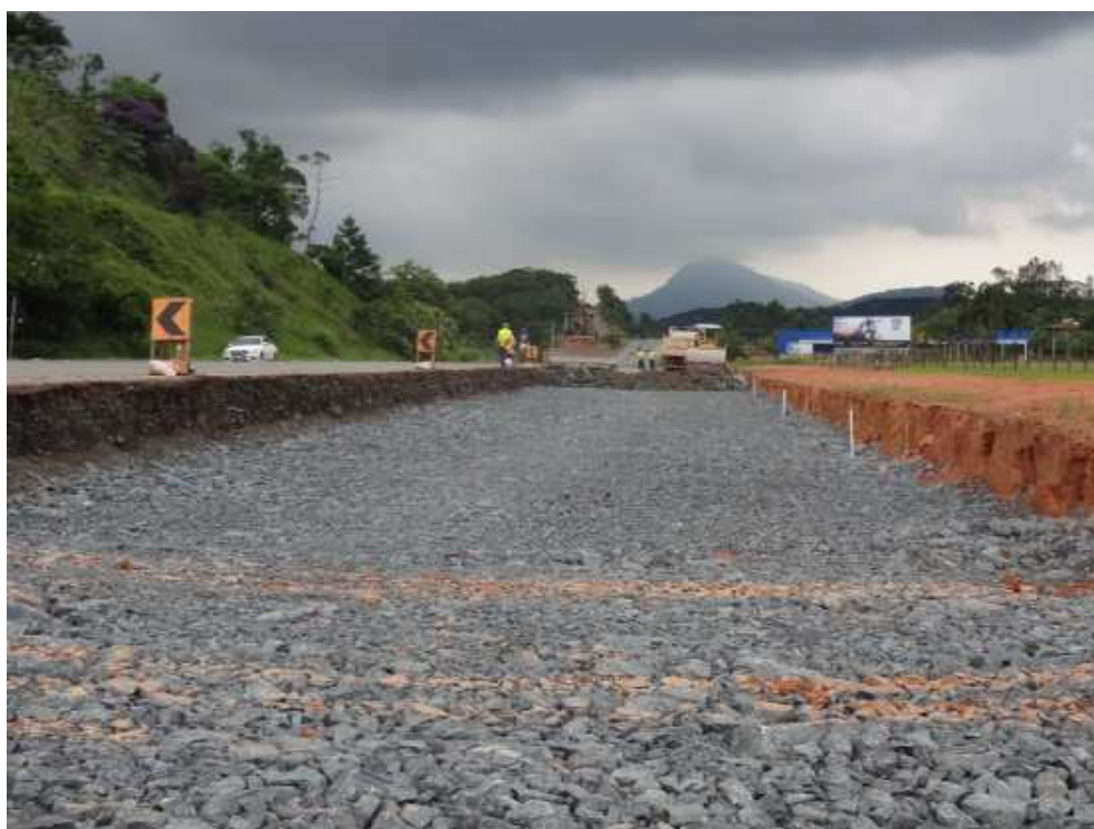
Figura 12: Km 45,5 - Execução da base da nova pista
