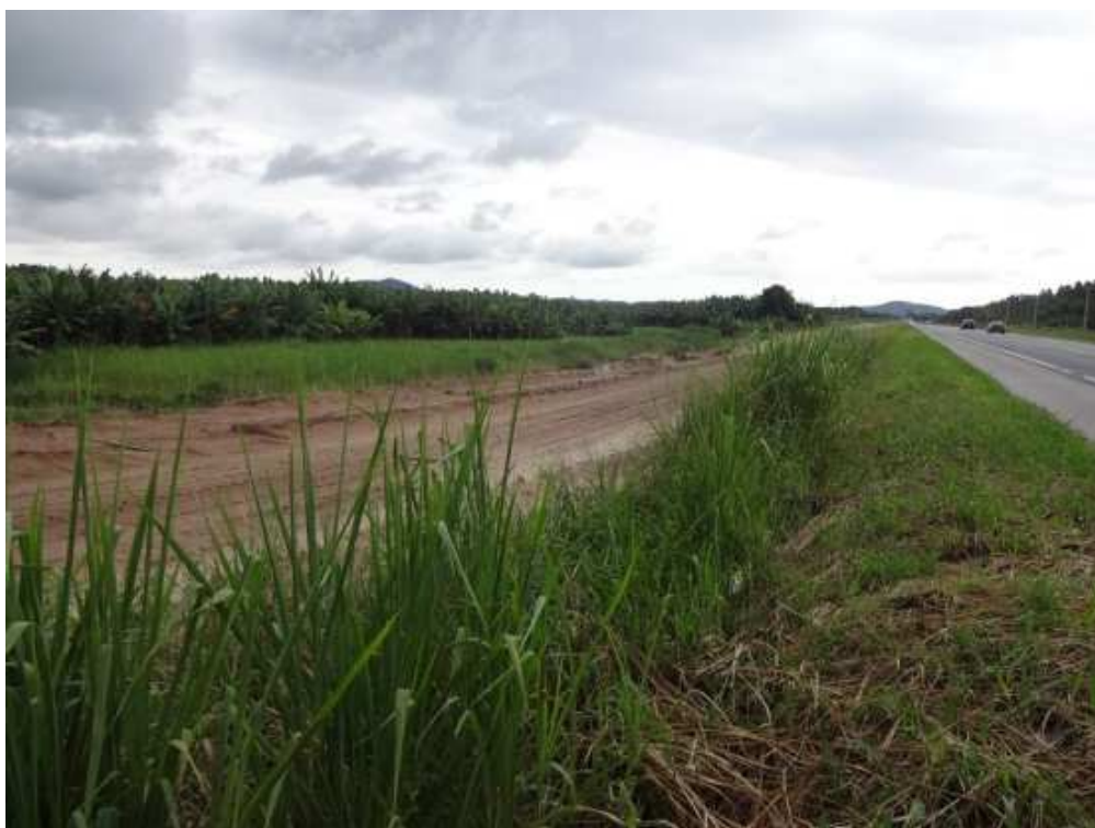
Figura 14: Execução de colchão drenante - km 41 ao 44
