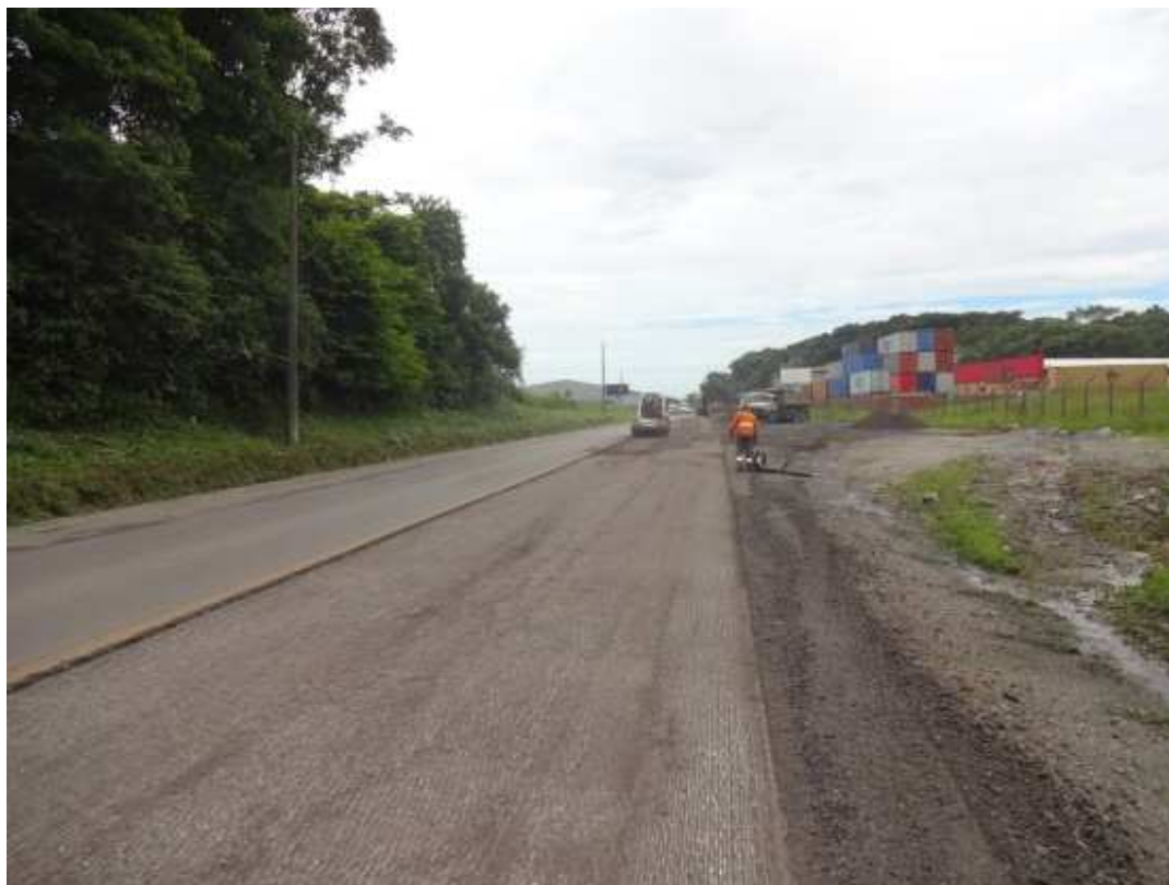
Figura 20: Correção de defeitos por meio de fresagem contínua - Entre km 1,7 e 2,5
