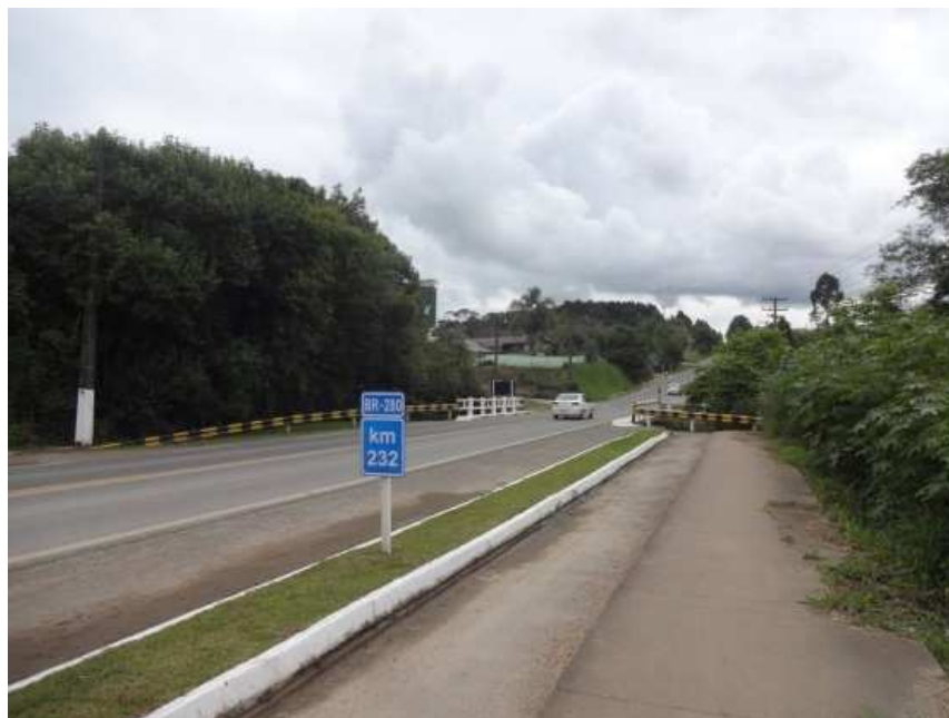
Figura 28: Início do trecho "federalizado", em Canoinhas - km 232,0
