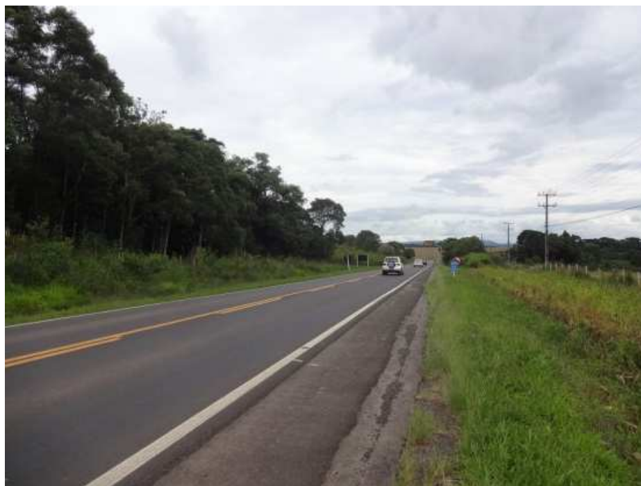
Figura 30: No segmento Canoinhas/ Porto União o acostamento é de somente 1,3 metros
