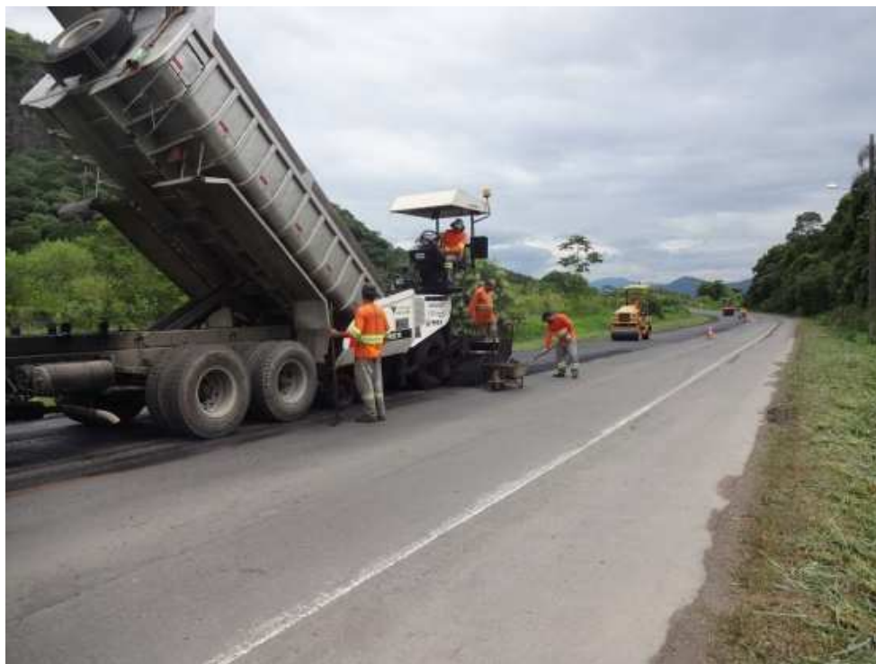
Figura 18: km 1,8 - Execução de nova capa asfáltica
