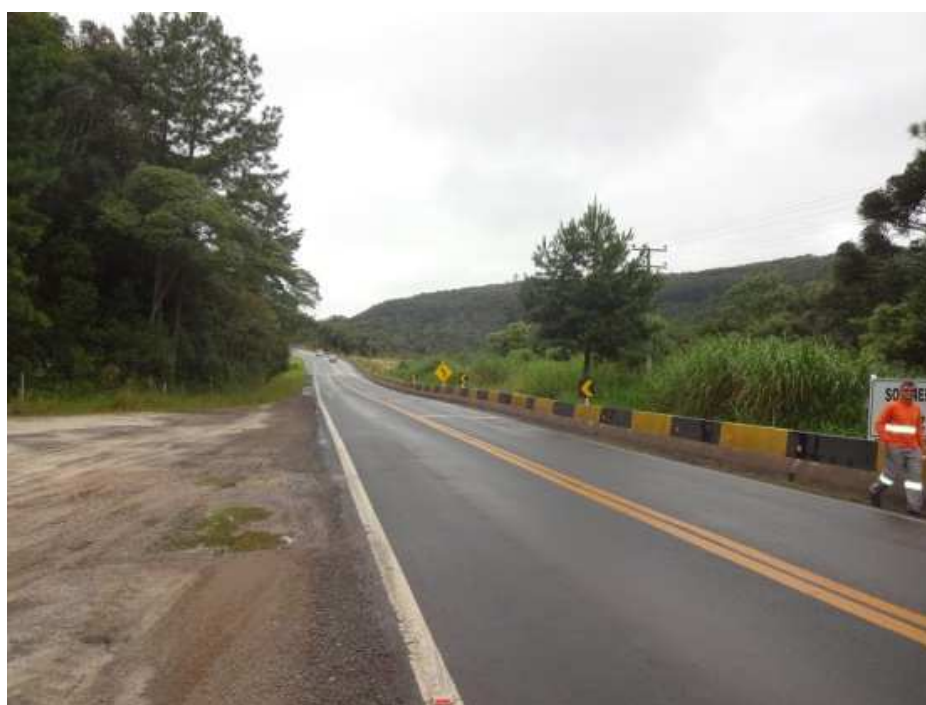
Figura 29: km 297,0 - Trecho em obras
