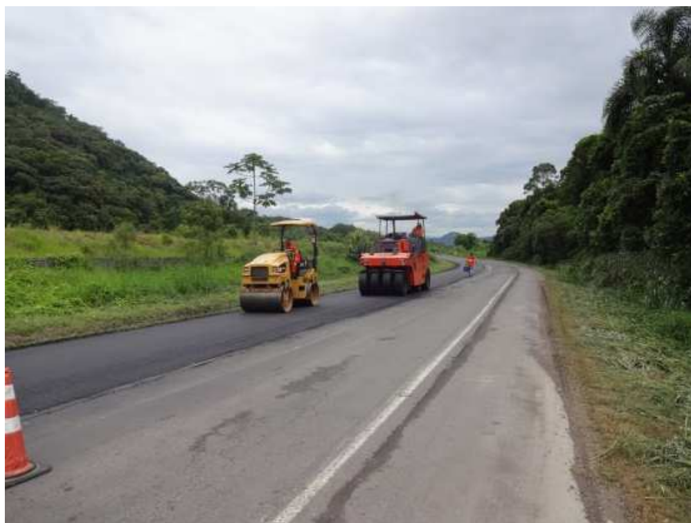
Figura 19: Outra vista da recuperação do pavimento
