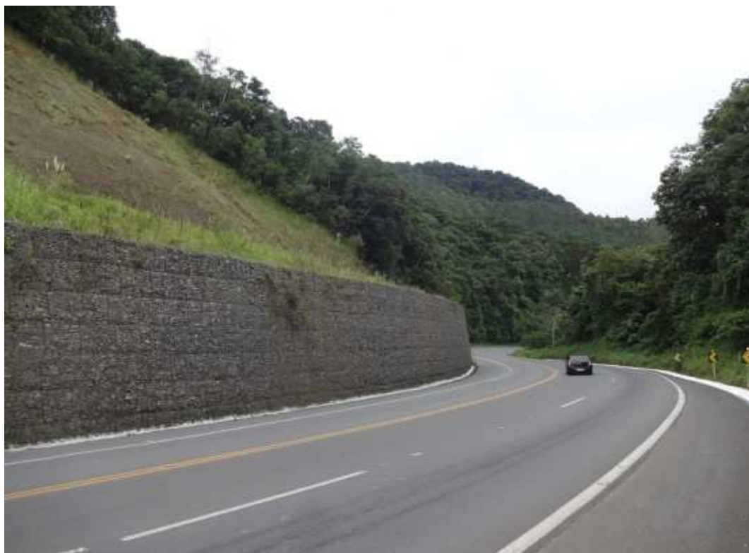
Figura 22: Muros de contenções - km 95,0
