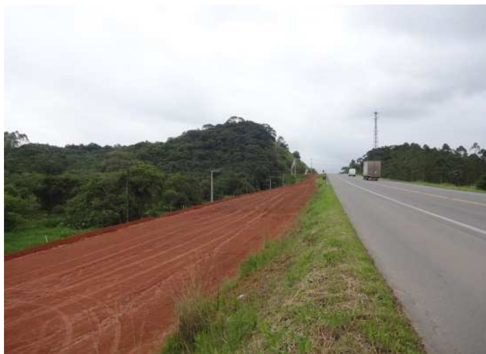
Figura 11: Terraplenagem- Nova pista.... km 47,7
