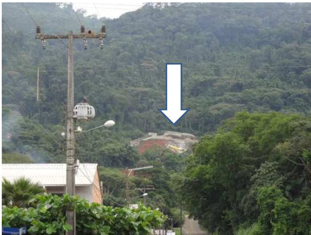
Figura 16: Embocamento leste do túnel sob o Morro Vieira
