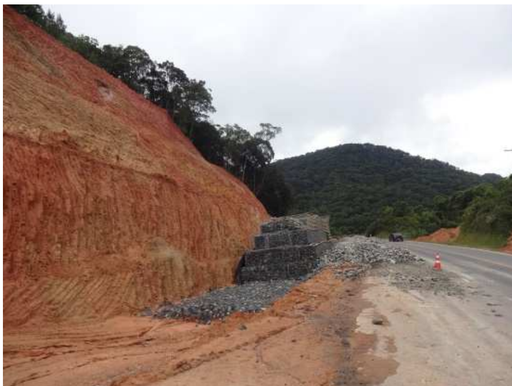
Figura 24: Contenção em execução no km 106,0
