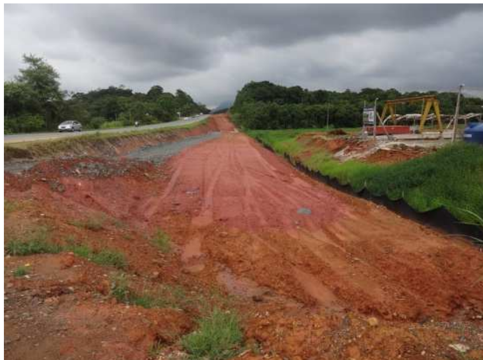
Figura 13: Km 44,6 - Terraplenagem sobre geotêxtil
