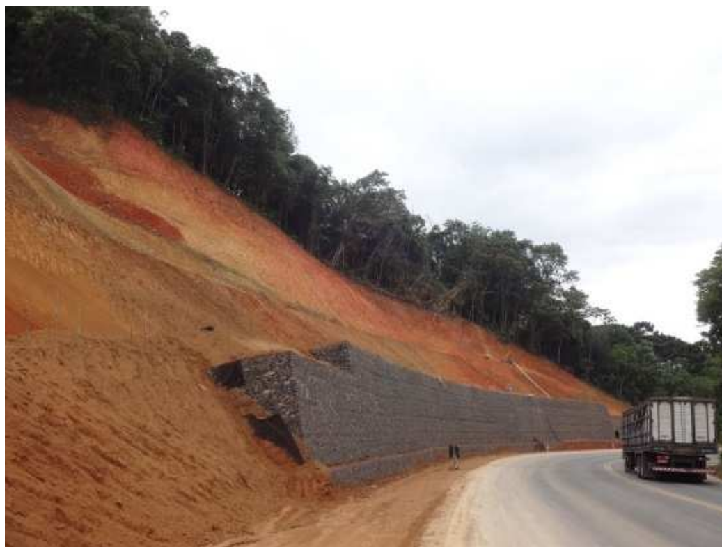
Figura 23: km 104,5 - Muros de contenções e enleivamento de taludes
