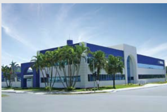
Unidade do SENAI em Joinville foi ampliada e revitalizada
