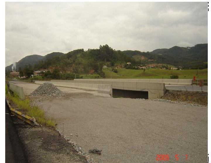
COMENTÁRIO: Pontes sobre o Rio Correias.
