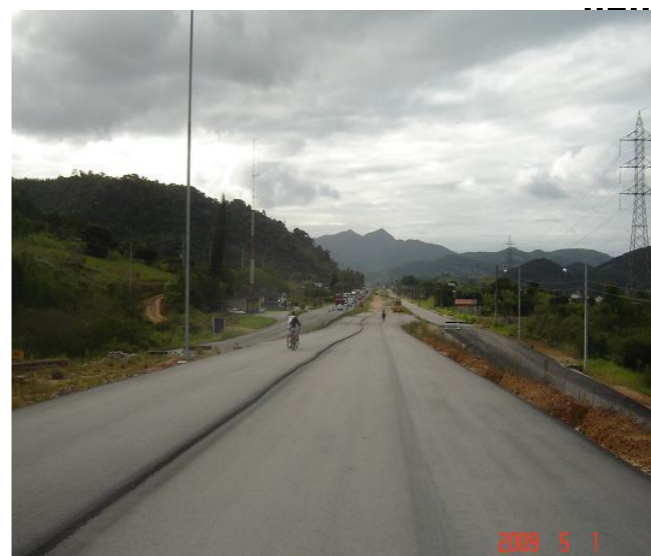
COMENTÁRIO: Localidade do atual Posto da Polícia Rodoviária Federal. Observa-se que todo o trânsito está passando por uma via coletora, enquanto que a pista principal está em fase da execução da capa asfáltica.
