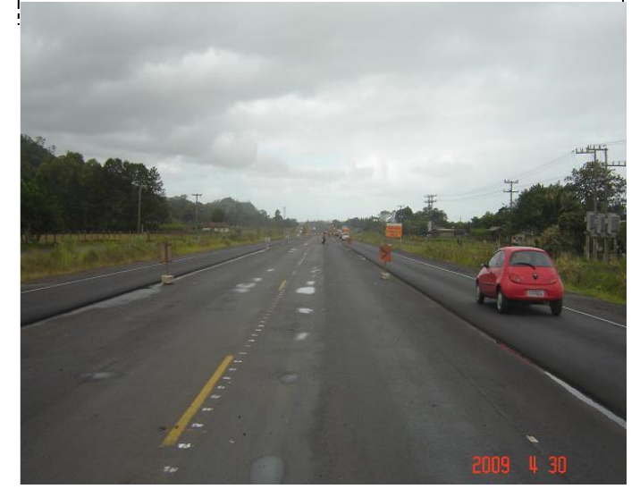
COMENTÁRIO: Pista com parte da capa asfáltica executada.
