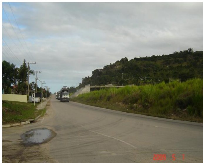
COMENTÁRIO: Via coletora e passagem inferior de acesso a Penha, observando-se que o aterro das cabeceiras não foram executados.
