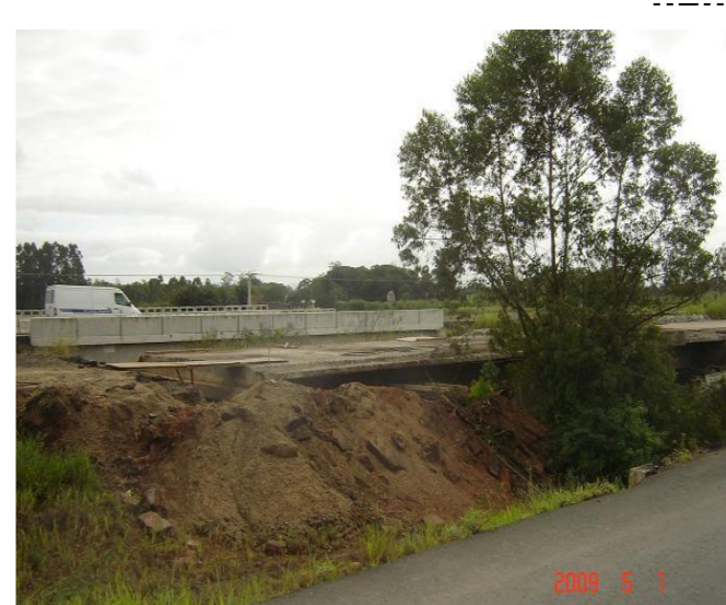
COMENTÁRIO: Ponte sobre o rio dos Porcos, pista Sul/ Norte, em serviços de recuperação.
