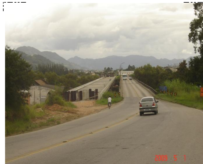
COMENTÁRIO: Ponte sobre o Rio Tubarão ( sentido Norte/Sul) , em fase de conclusão. Observa-se também a ponte em uso, a qual, aparentemente de ser objeto de recuperação.
