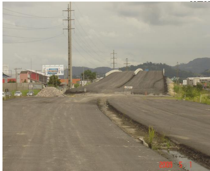
COMENTÁRIO: Viaduto duplo de acesso a Tubarão- Norte. Observa-se a execução da capa asfáltica da cabeça norte do mesmo.
