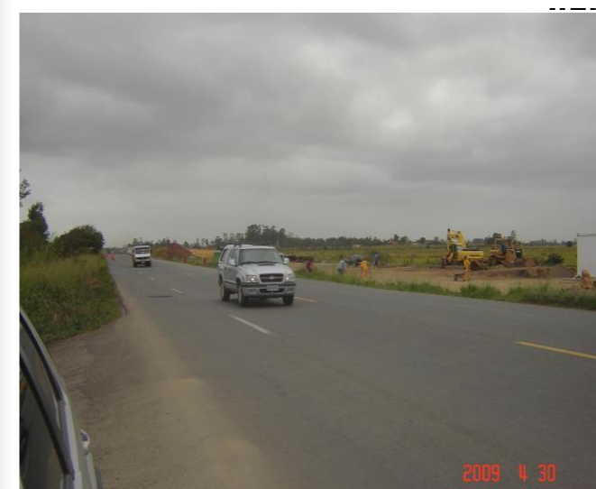
COMENTÁRIO: Serviços de terraplenagem no trecho entre os dois viadutos de transposição do banhado de Maracajá.
