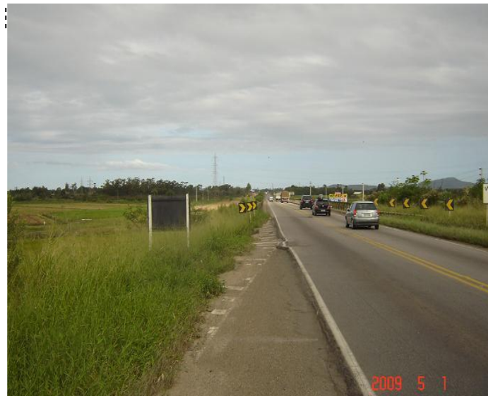
COMENTÁRIO: Ponte velha, sobre o Rio Araçatuba, suportando todo o trânsito. A outra ponte ( sentido Sul/Norte) não foi iniciada.
