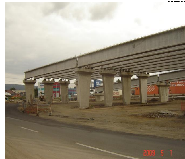
COMENTÁRIO: Outra vista do viaduto duplo do acesso principal de Tubarão
