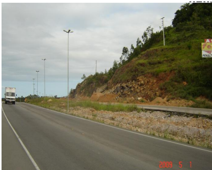
COMENTÁRIO: Corte, com incidência de rocha - pista Norte/Sul -próximo a ponte do Rio Araçatuba.
