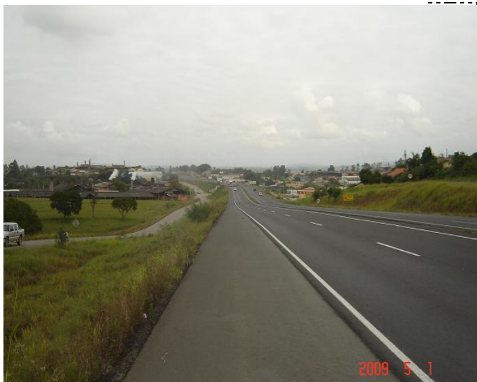
COMENTÁRIO: Vista global do trecho no acesso a Morro da Fumaça. Pistas duplicadas e vias coletoras.
