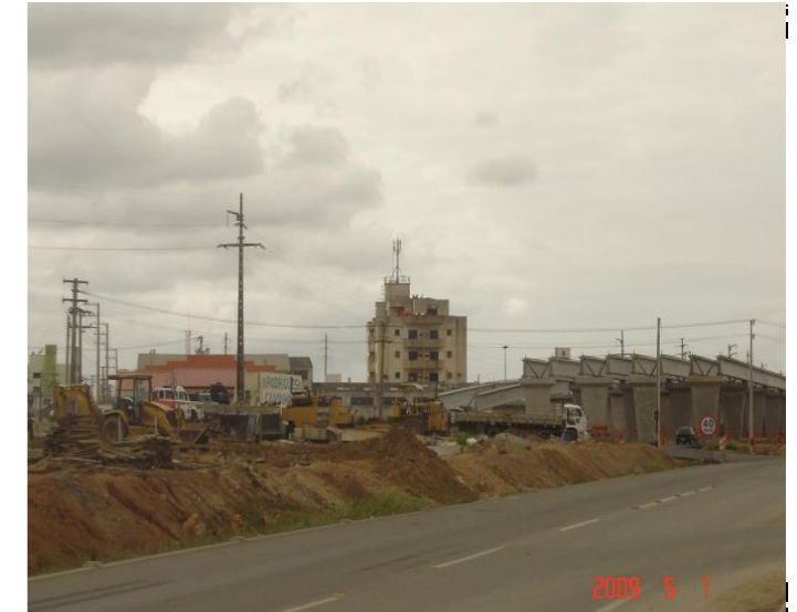
COMENTÁRIO: Vista das obras de construção do Viaduto Duplo de acesso aos Bairros São João e Morretes.
