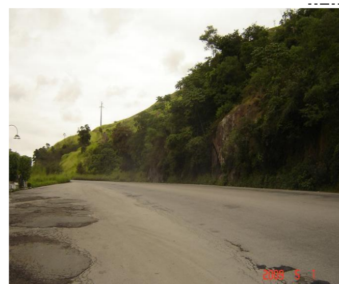
COMENTÁRIO: Morro do Formigão, onde será executado um túnel, com duas galenas.
