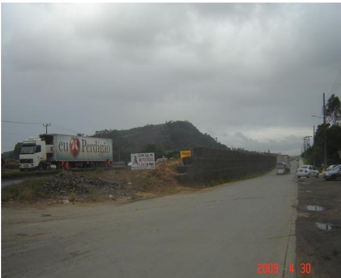
COMENTÁRIO: Local da passagem inferior do acesso Maracajá- Sul, observando-se as contenções executadas com gabioes de pedras.
