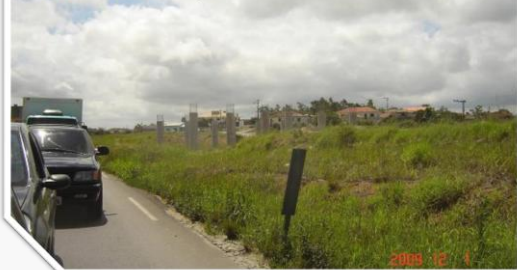
LOCAL DA OBRA PARALISADA - PASSAGEM INFERIOR DE ACESSO KM. 37,0
