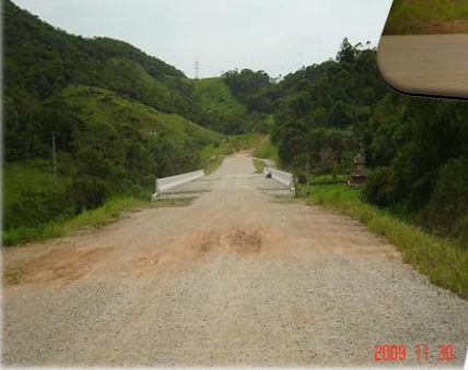
PONTE SOBRE O RIO COVA TRISTE II - SUB TRECHO VARIANTE
