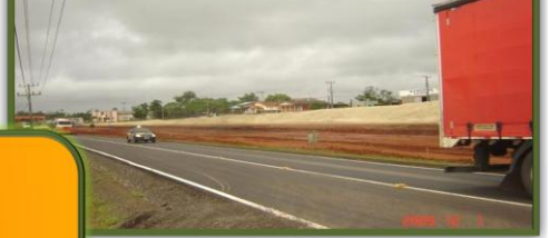
SANTA ROSA DO SUL - VILA GLORINHA - ATERRO CABECEIRAS EM PASSAGEM INFERIOR
