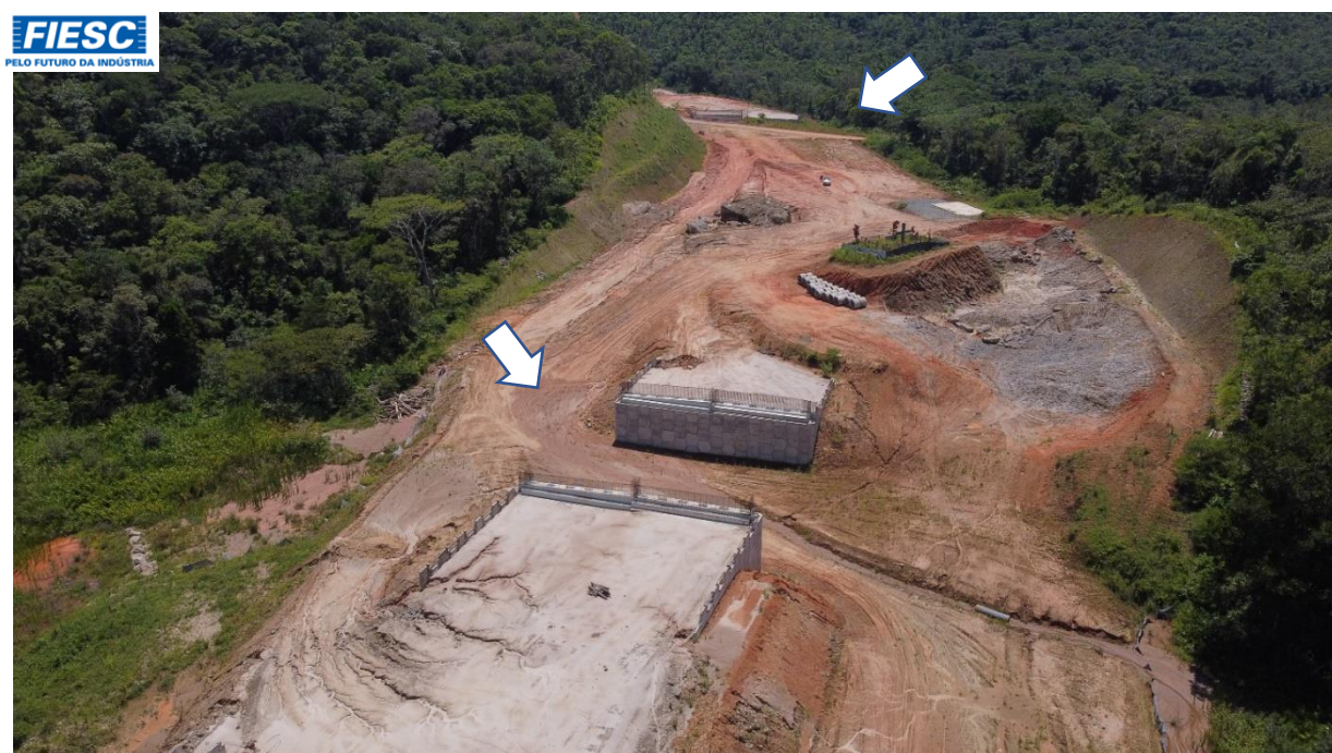
12: VIADUTO EM EXECUÇÃO NO Km 11+238 - NOVO TRAÇADO
