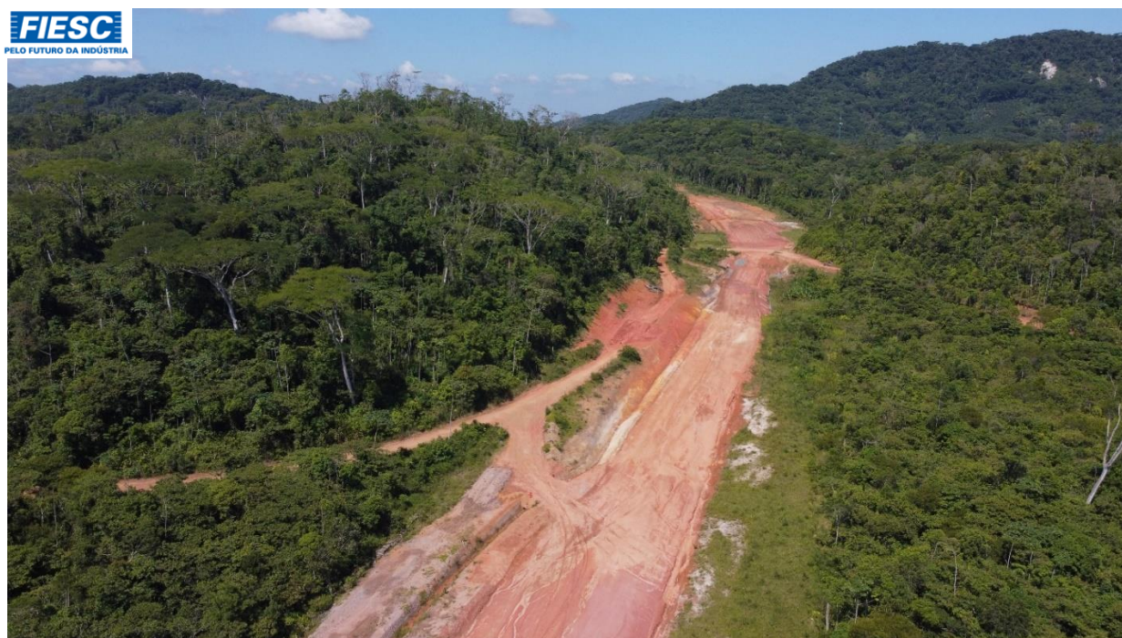
9: OUTRO SEGMENTO PRÓXIMO AO Km 10,7 EM IMPLANTAÇÃO
