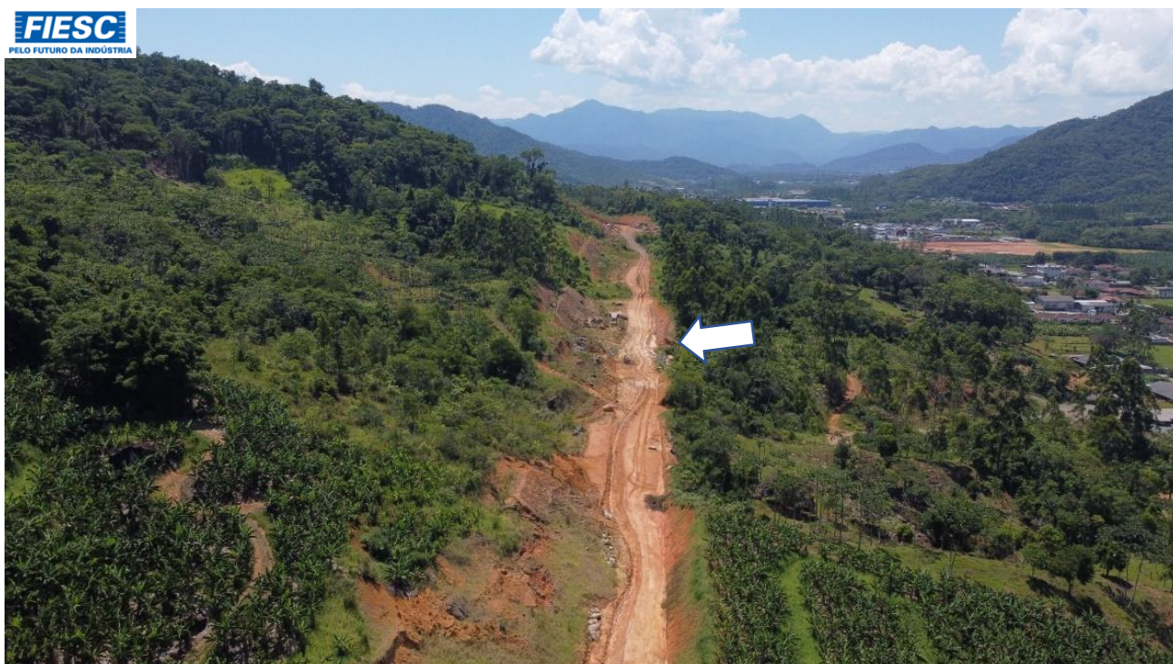
37: SEGMENTO EM IMPLANTAÇÃO ENTRE Km 60 E 66,0.
