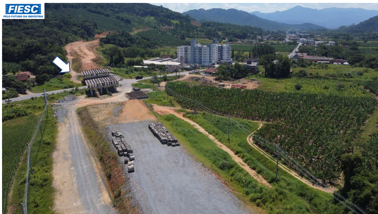
36: PASSAGEM SUPERIOR SOBRE A SC-108, EM SCHROEDER
