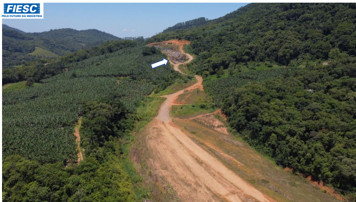
29: OUTRA VISTA DAS OBRAS DE IMPLANTAÇÃO
