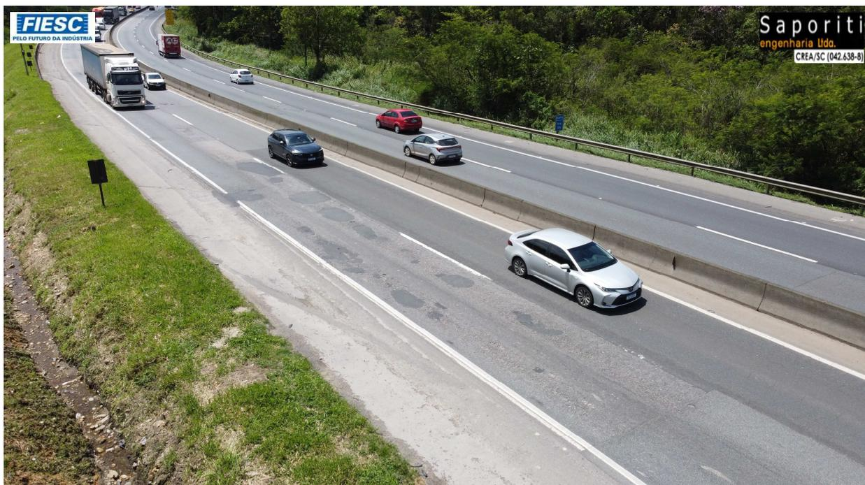
6: Km 55 - Buracos, trincamentos e desagregação do pavimento - Pista Sul
