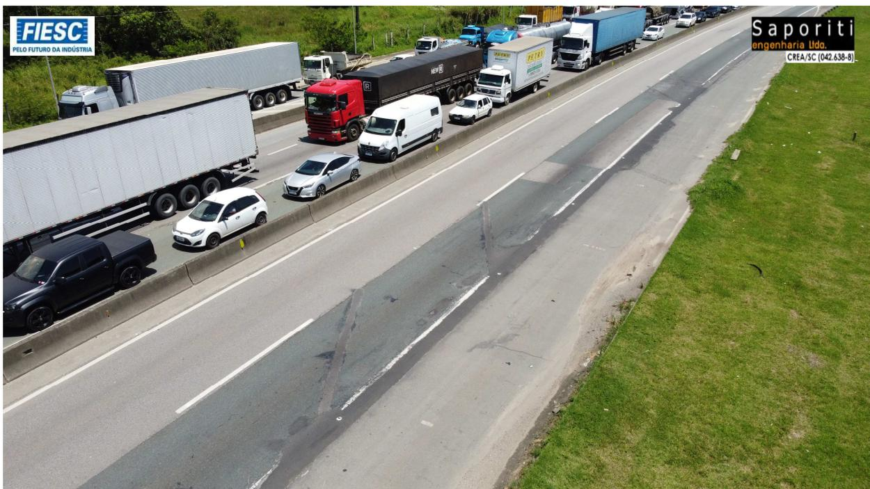
**4:** Desagregação do pavimento no km 102
