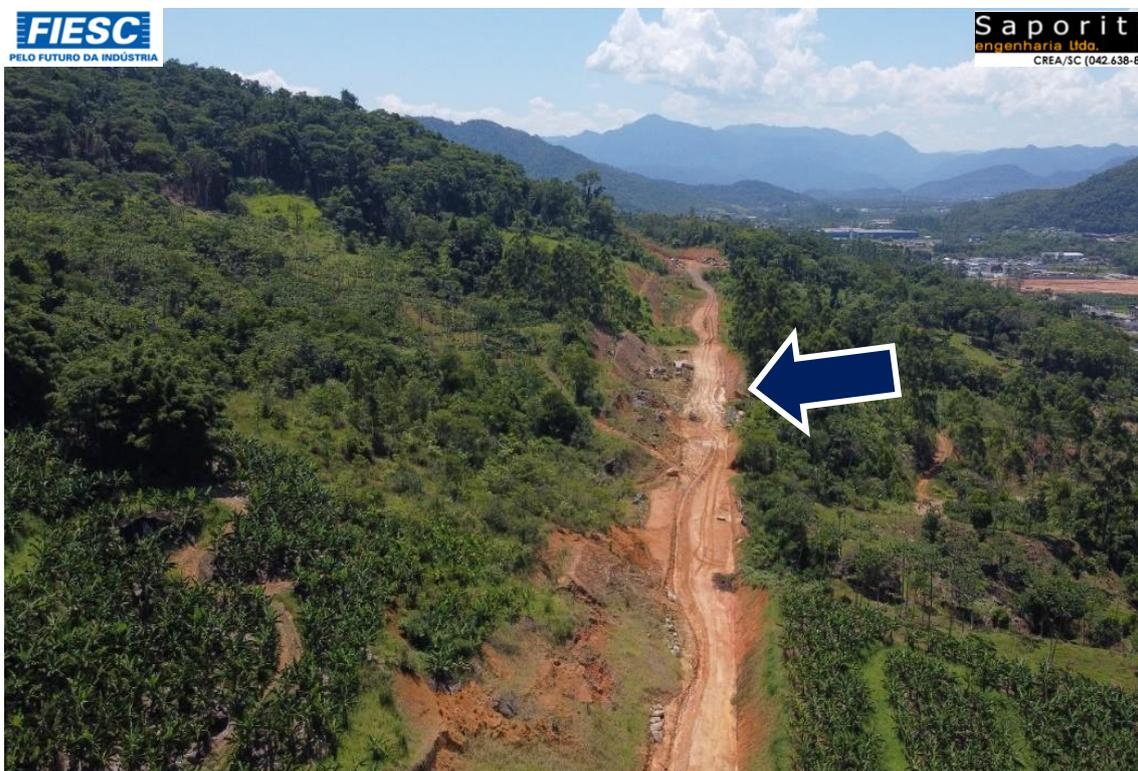
38 - OBSERVA-SE O CORTE "CAIXÃO" EM ROCHA, NO SEGMENTO ACIMA
