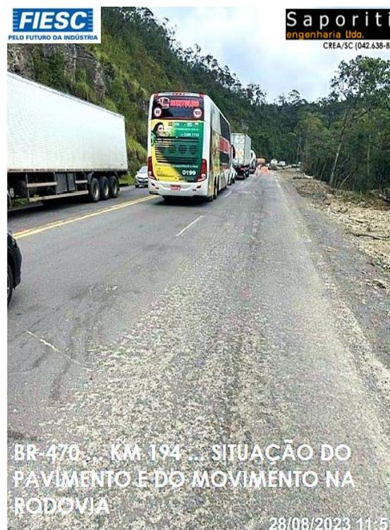
Do km 196 ao km 213 a situação do pavimento é de regular a boa, enquanto do km 214 até o entroncamento com a BR-116/SC (São Cristóvão do Sul), apresenta alguns poucos pontos com deformações e bem-sinalizado.
