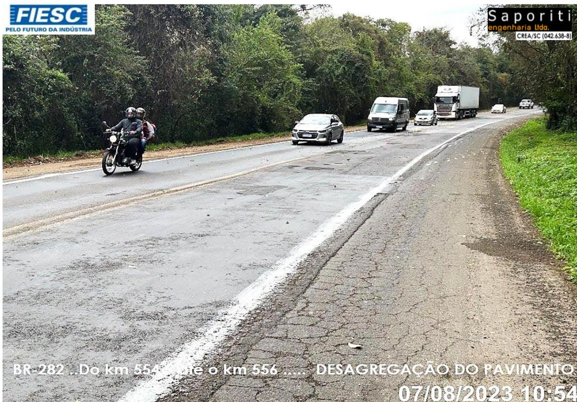
BR-282 .. Do km 554,0 até o km 556,0 ..... DESAGREGAÇÃO DO PAVIMENTO
