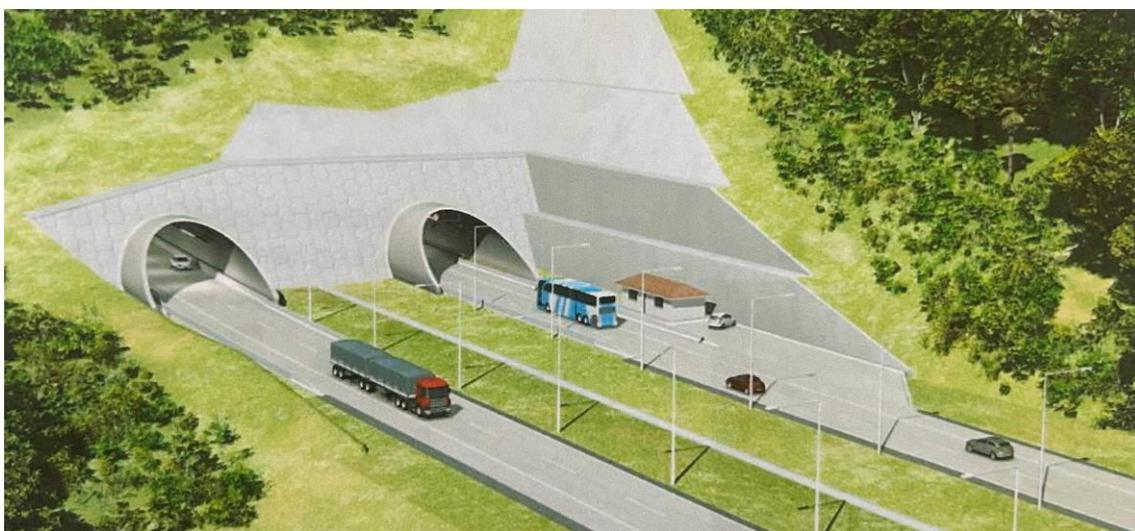
**27** - Estimativa do posicionamento do Embocamento Norte do Túnel projetado
