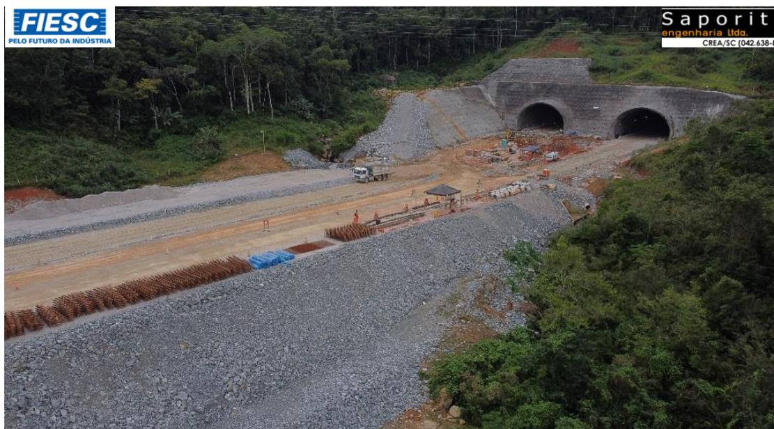
**TRECHO VIÁRIO SUL:** Compreendido entre os km 223+385 (Embocamento Sul do Túnel 02) ao km 233+000 (entroncamento BR-101 S). Este segmento ainda apresenta um grande número de obras de terraplenagem, pavimentação e obras de artes especiais, a serem executadas.
