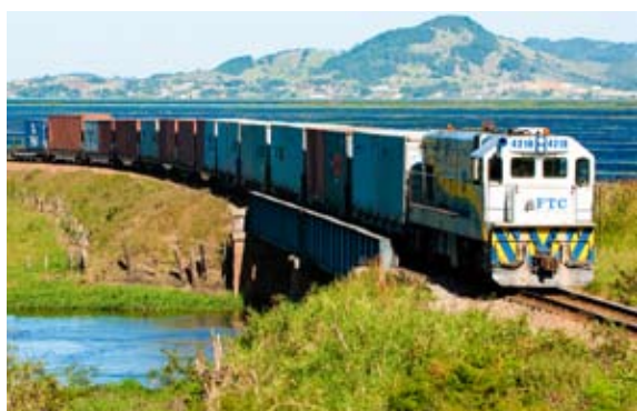
Projeto da Ferrovia Litorânea prevê integração de SC à malha nacional
