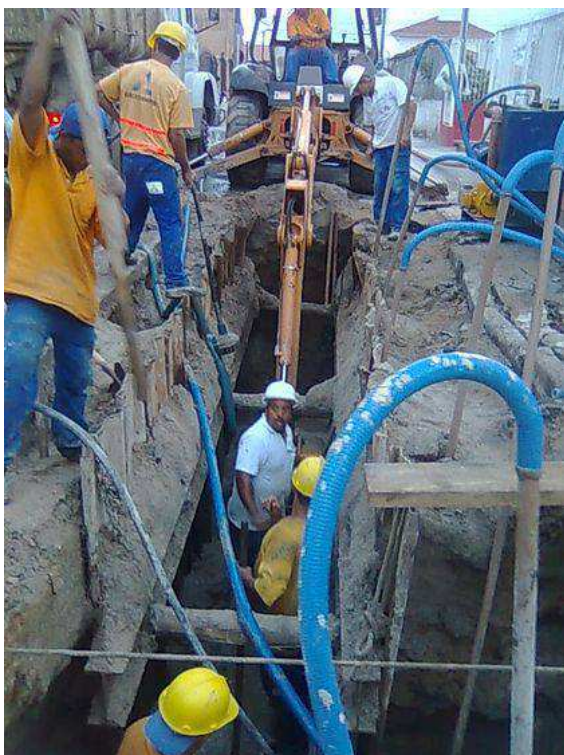
ESGOTO SÃO JOSÉ
