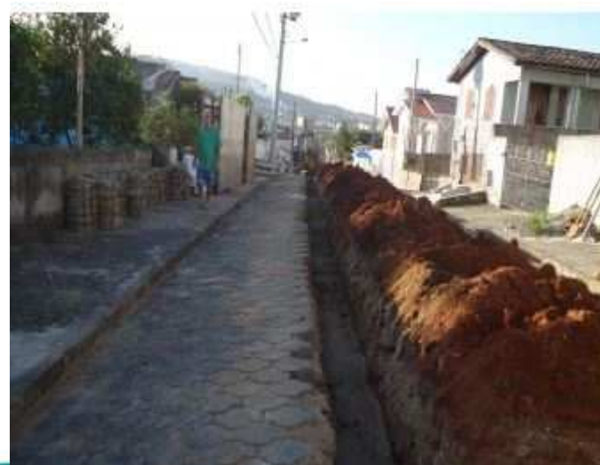
ESGOTO CRICIÚMA - PRÓSPERA
