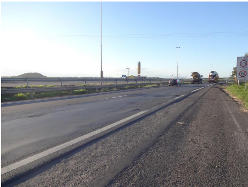
Ilustração 15- Passo de Torres (SC)- km 465- Situação dos pavimentos e acostamento na pista norte.
