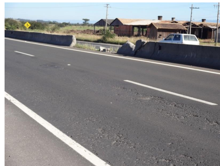
Ilustração 51- Km 365,5 (pista norte)- Recuperação de Barreiras New Jersey e situação do pavimento.
