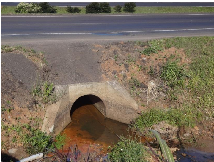
Ilustração 33- Km 76 (RS) - Necessidade de desobstrução e limpeza dos sistemas de drenagens ao longo da rodovia.
