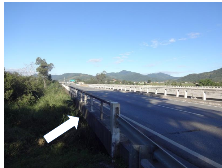
Ilustração 34- Recuperação emergencial da ponte sobre o Rio Paulo Lopes- km 251.
