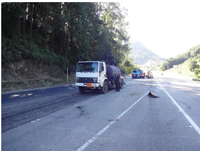
Ilustração 8- Cabeceira da ponte sobre o Rio Cova Triste 1- Recomposição do pavimento com reparos superficiais.
