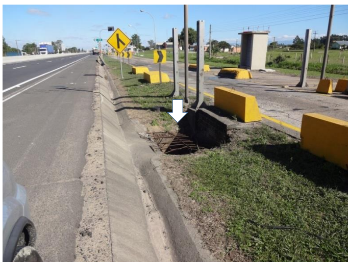
Ilustração 65- Km 418,3 - Posto de pesagem (Vide caixa coletora de sarjeta).
