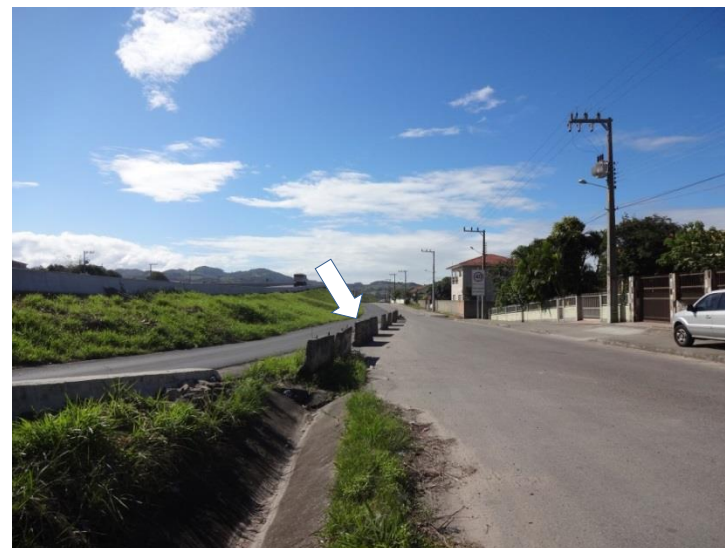
Ilustração 63- Km 325,8 (pista norte): Mais segurança nos entroncamentos das saídas da pista com ruas laterais.
