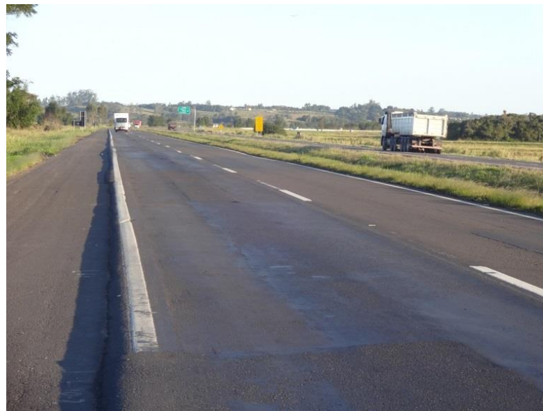
Ilustração 14- Situação da pista de rolamento e do desnível do acostamento (km 463,5) num segmento de aproximadamente 6 km- pista norte.
