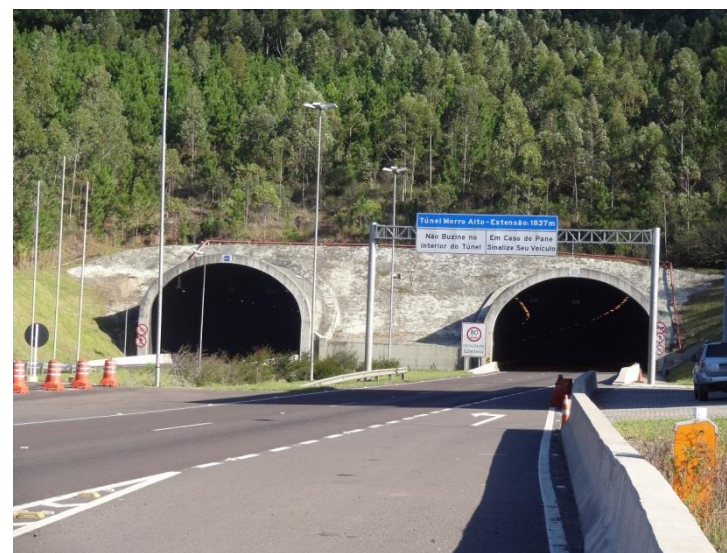
Ilustração 47- Túnel do Morro Alto (km 67/RS), com extensão de 1.837 metros.
