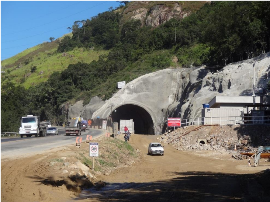
Ilustração 6- Transposição do Morro do Formigão- Túnel com 900 metros de extensão, com conclusão prevista para maio/2015.
