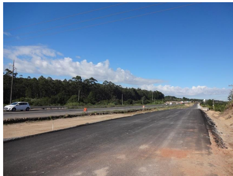
Ilustração 2- Travessia de Laguna (km 308 ao 313,1)- Obras de duplicação e implantação de ruas laterais- Em execução.
