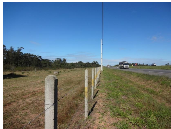
Ilustração 26- Km 271,5 (pista norte): Modelo de cerca para delimitação da faixa de domínio.
