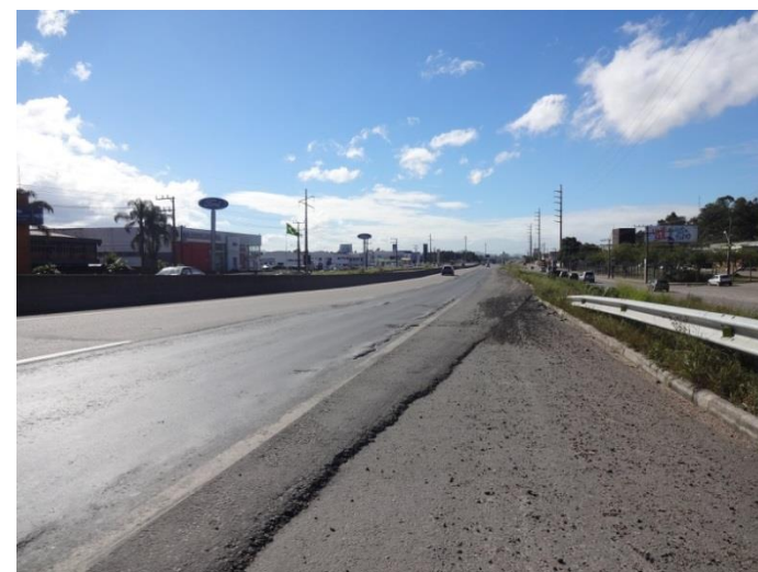
Ilustração 10- Contorno urbano de Tubarão (pista norte)- Afundamento do pavimento (km 336,6).
