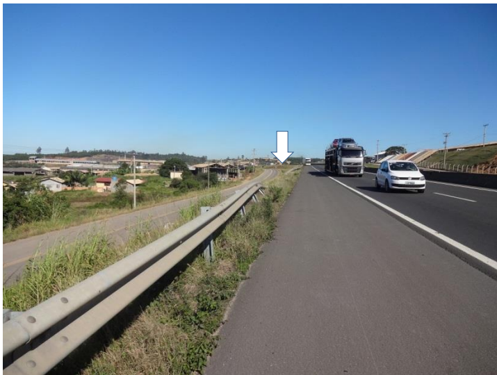
Ilustração 48- Km 362,3 (pista norte): Substituição de defesa metálica.
