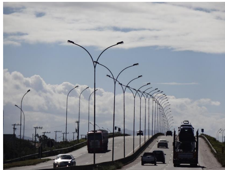
Ilustração 58- Km 297,2- Viaduto de acesso a Itapirubá - Ativação da iluminação.
