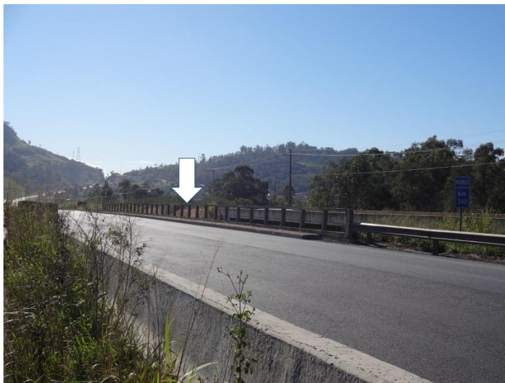
Ilustração 40- Km 340- Alargamento e reforço da ponte sobre o Rio Correias.
