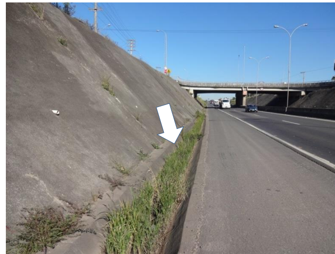
Ilustração 30- Viaduto de acesso a Rincão e Criciúma- Má conservação dos sistemas de drenagens.
