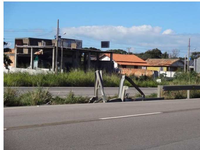
Ilustração 50- Substituição de defesa metálica (km 288).
