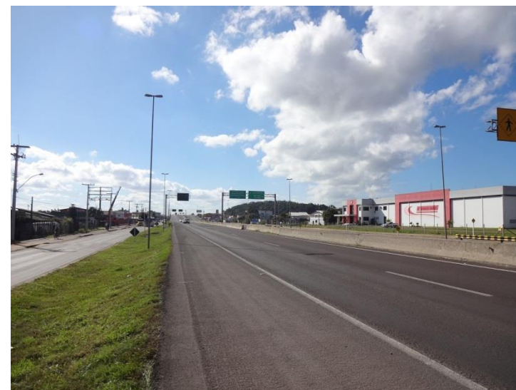
Ilustração 43- Km 2 (RS) - Necessidade de implantação de passarela.
