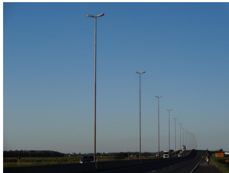
Ilustração 59- Acesso a Passo de Torres (SC)- Ativação da iluminação da passagem inferior no km 464,2.
