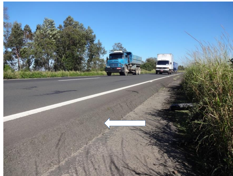
Ilustração 21- Km 374, pista norte: Desnível entre a faixa de tráfego e lateral (aproximadamente 25 cm).
