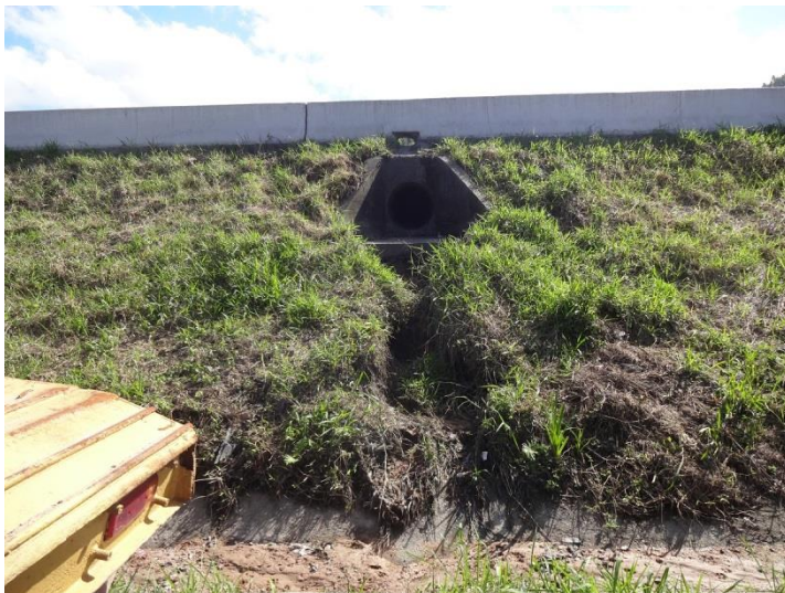
Ilustração 56- Km 327,5 (pista norte)- Recuperações de saídas d'água (descidas de água) e bocas de bueiros.
