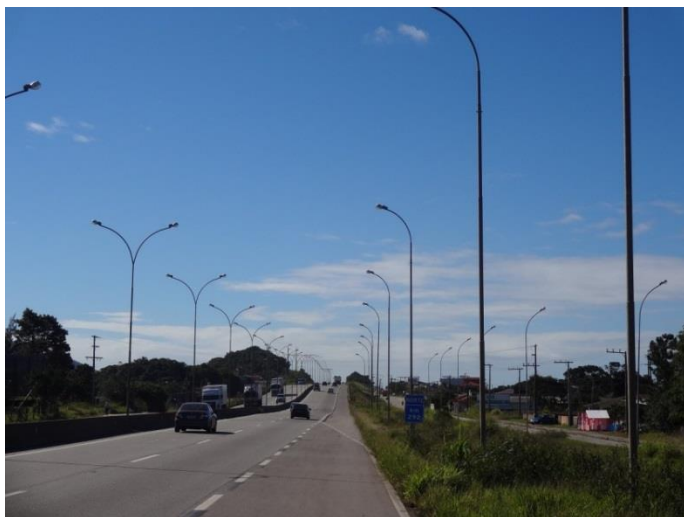
Ilustração 57- Ativação do sistema de iluminação pública e manutenção nos trevos e viadutos.
