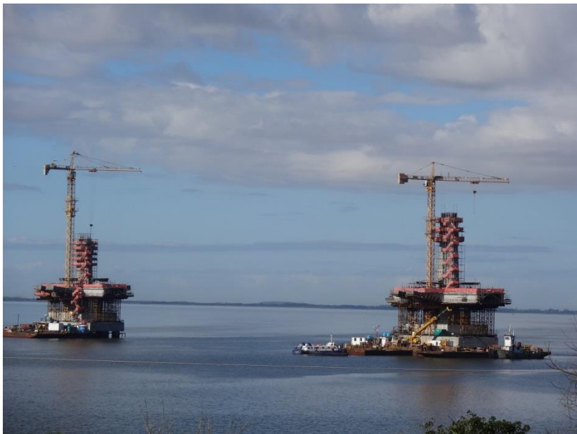
Ilustração 4 - Obras de transposição da Lagoa de Cabeçuda e do Canal Laranjeiras- Extensão 2815m - Em execução.
