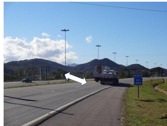
Ilustração 42- Travessia urbana do município de Paulo Lopes - Execução de viaduto.
