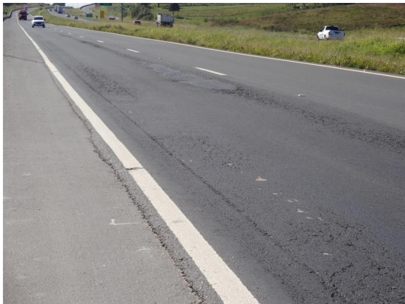
Ilustração 12- Km 371,5- Degradação do pavimento, com maior incidência nas faixas direitas das pistas norte e sul.
