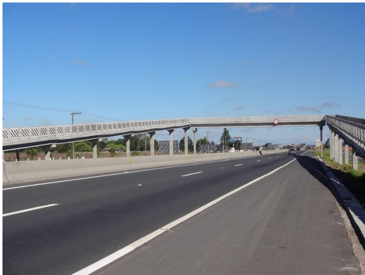
Ilustração 27- Iluminação e alambrados protetores na passarela - km 419.
