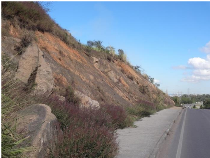
Ilustração 60- Km 330,3 (rua lateral, na pista norte)- Recuperação de passivo ambiental.
