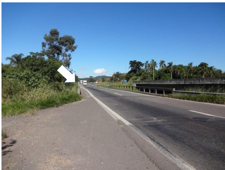
Ilustração 41- Ponte sobre o Rio Cubículos (km 346,3)- Reforço e alargamento.
