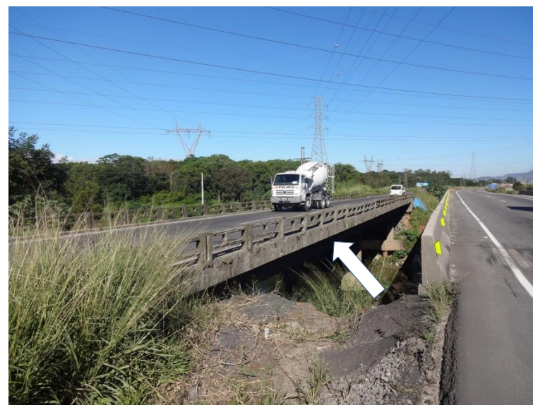
Ilustração 39- Ponte sobre o Rio Capivari- Alargamento e reforço (km 330).
