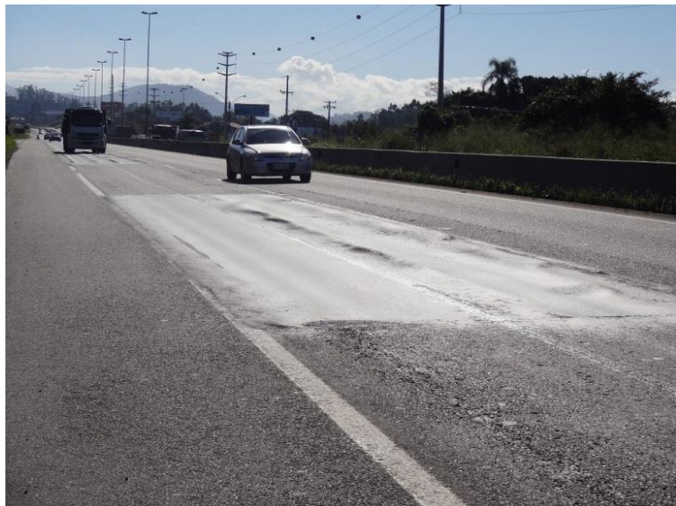
Ilustração 11- Pista sul- Deformação plástica do pavimento.
