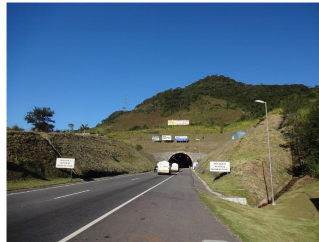
Ilustração 46- Operação do sistema de segurança do túnel do Morro Agudo (km 257,5).
