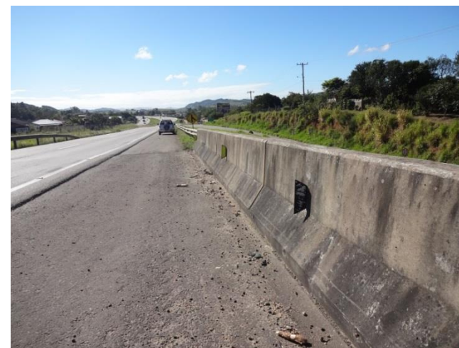
Ilustração 55- Sinalizações refletivas- Deficientes em inúmeras pontes, viadutos, Barreiras New Jersey e defensas metálicas (km 355).
