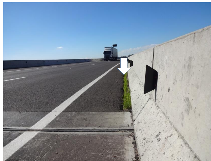
Ilustração 31- Km 410- Viaduto banhado de Maracajá- Limpeza do sistema de drenagem.
