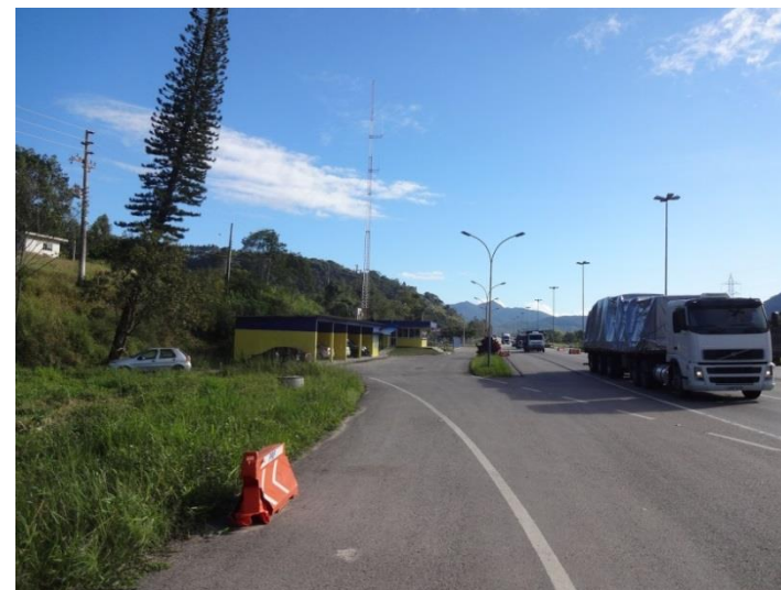
Ilustração 67- Construção de novas instalações para a Polícia Rodoviária Federal.
