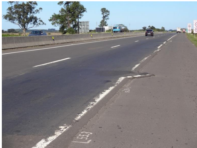
Ilustração 13- Km 457,5 (pista sul)- Irregularidade longitudinal no pavimento flexível.
