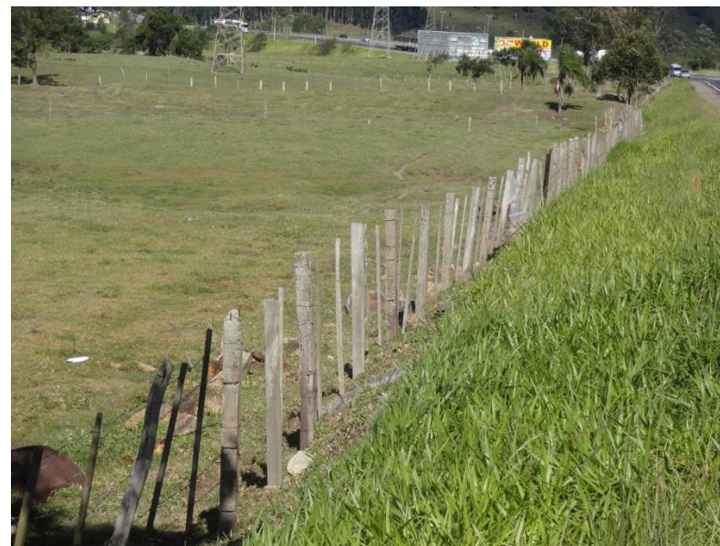
Ilustração 25- Cercas na faixa de domínio (km 267,3).
