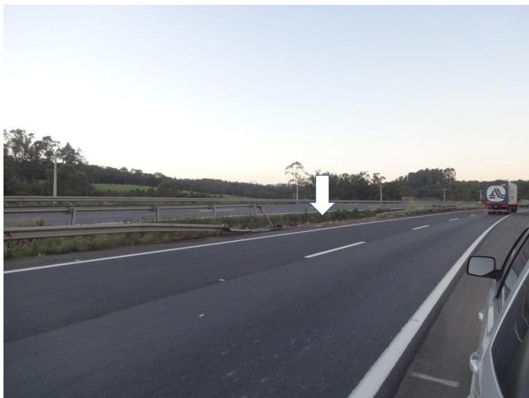
Ilustração 49- Km 394, pista norte: Recuperação de defesa metálica.
