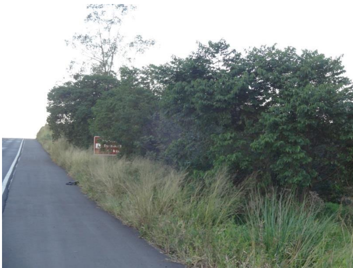
Ilustração 24- Km 440- pista norte- Falta de manutenção da faixa de domínio no segmento entre Sombrio e Passo de Torres.
