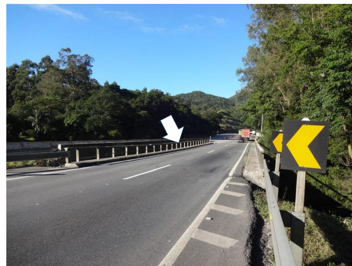
Ilustração 35- Recuperação e reforço da ponte sobre o Rio Cova Triste I (km 259).
