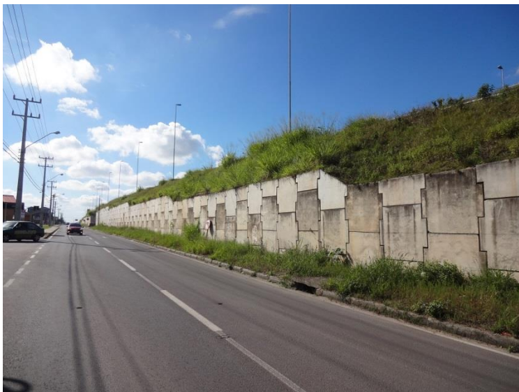
Ilustração 32- Passagem inferior no km 437 (Sombrio)- Manutenção deficiente.
