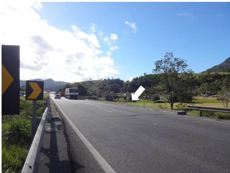
Ilustração 36- Reforma e reforço da ponte sobre o Rio da Penha (km 264,5).
