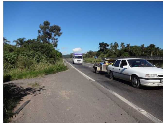
Ilustração 54- Recuperação da sinalização horizontal- Baixa refletividade das faixas existentes (km 346,5- pista norte).
