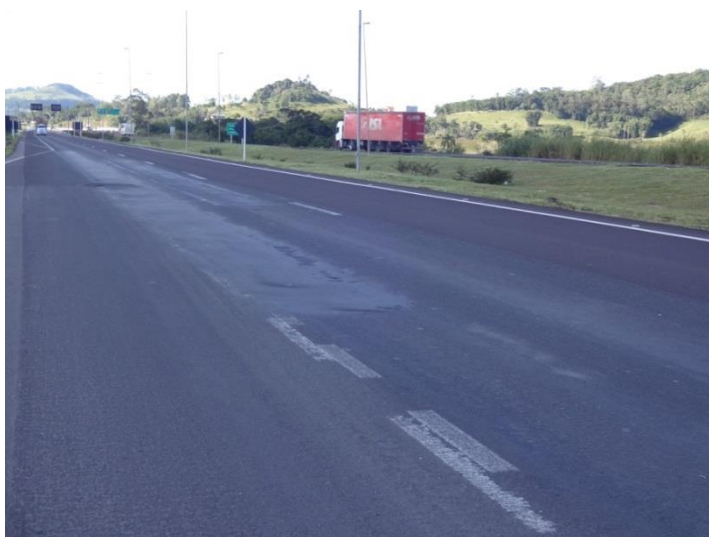
Ilustração 16- Km 21,5 (RS- Três Cachoeiras) - Flechas acentuadas nas trilhas de roda.
