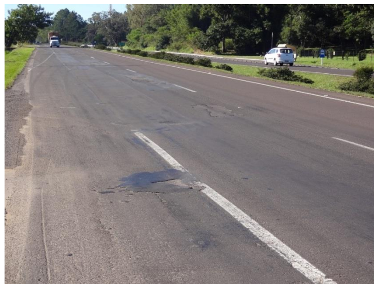
Ilustração 18- Km 76(RS) - Presença de deformações plásticas ou afundamentos num trecho de aproximadamente 1.300 metros.
