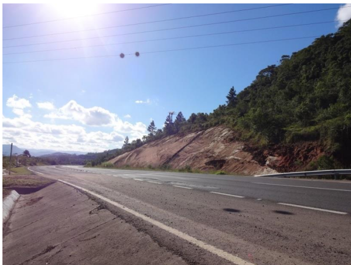
Ilustração 61- Km 15 (RS)- Recuperação de passivo ambiental.
