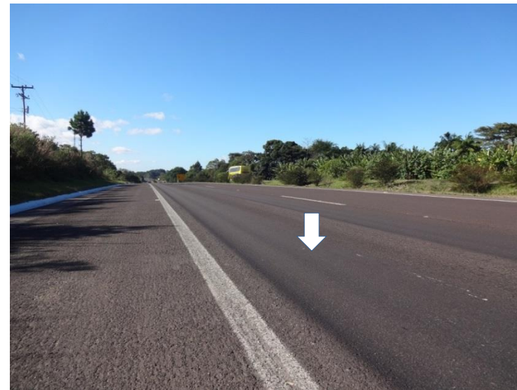
Ilustração 17- Km 55 (RS), pista sul- Afundamento plástico longitudinal na pista de rolamento.
