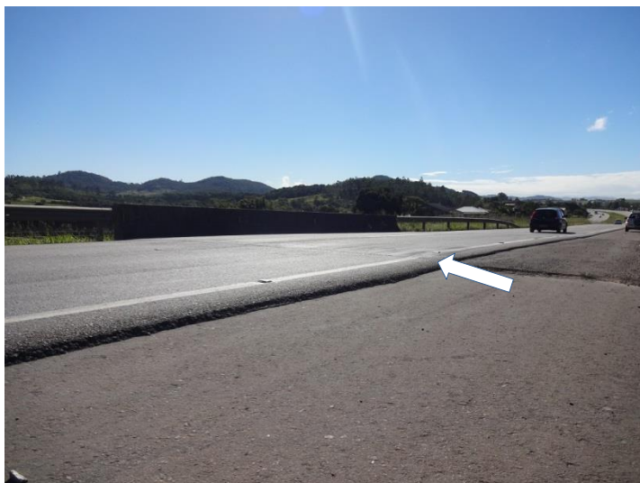
Ilustração 23- Passagem inferior de acesso a Sangãozinho (km 355,1- pista norte)- Desnível entre pavimento e viaduto.
