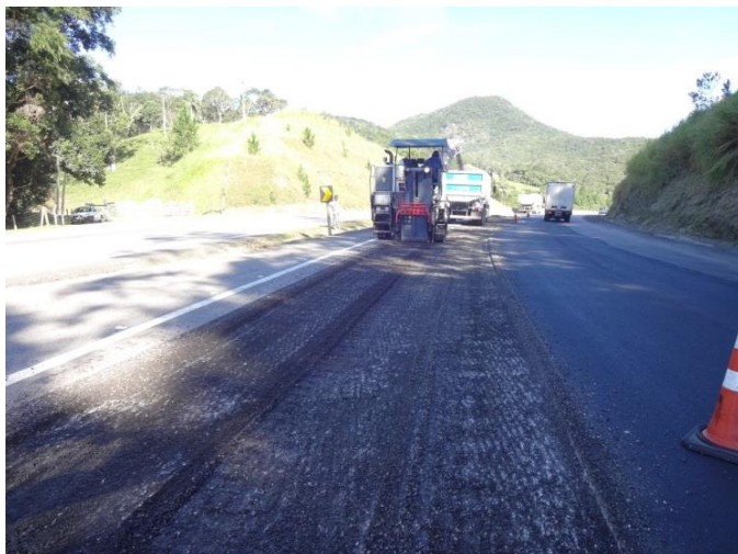
Ilustração 7- Km 259,2 (Pista Norte)- Remoção do pavimento com fresagem.
