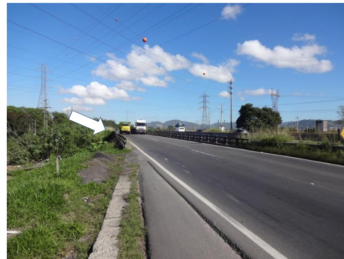
Ilustração 38- Km 330 (pista norte)- Reforço e alargamento da ponte sobre o Rio Capivari de Baixo.
