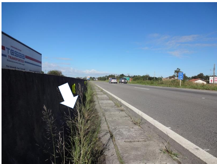
Ilustração 28- Km 296 (pista sul)- Limpeza dos sistemas drenantes.
