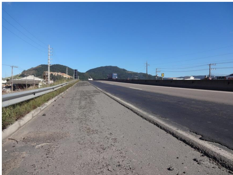
Ilustração 20- Km 336,5, pista norte: Necessidade de recuperação do pavimento e de limpeza dos acostamentos.
