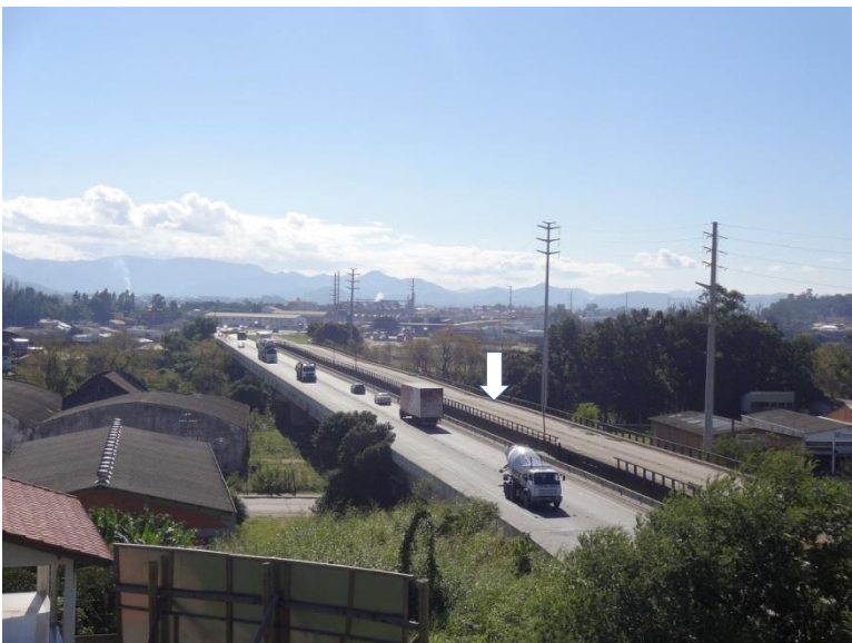
Ilustração 5- Ponte sobre o Rio Tubarão, que será reconstruída pelo DNIT.
