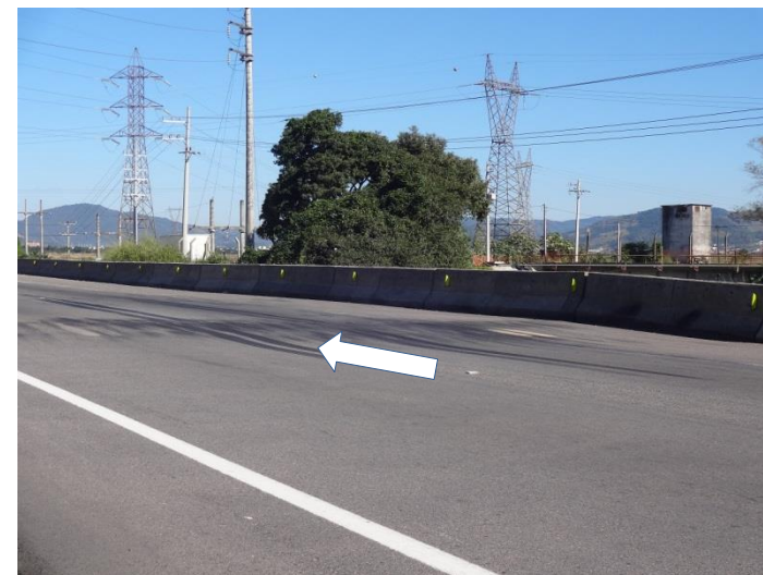
Ilustração 22- Km 329,7 - Desnível no acesso da ponte sobre o Rio Capivari.
