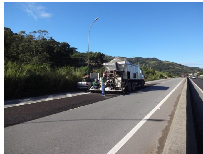
Ilustração 9- Pista Norte, no km 285- Aplicação de camada de microrrevestimentos, apenas para melhorar provisoriamente as condições de rolagem.
