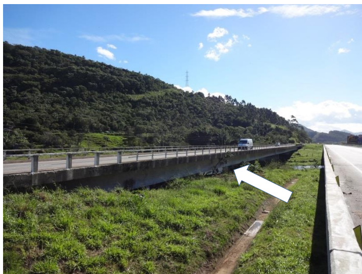
Ilustração 37- Alargamento e reforço (passando para TB-45) da ponte sobre o Rio Araçatuba (km 271).
