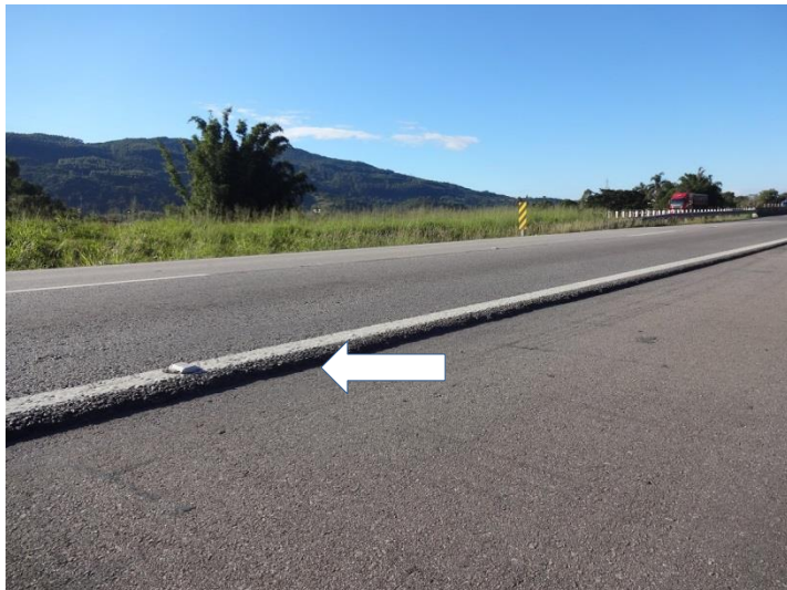
Ilustração 19- Manter, ao longo da rodovia, desnível inferior a 5 cm entre a faixa de tráfego e o acostamento (km 264).
